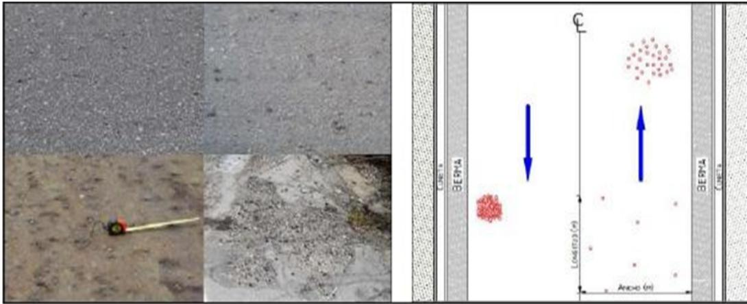
Figura 2.21: Desprendimiento de agregados.
