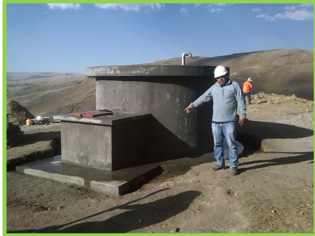
Figura 18: Reservorio apoyado
