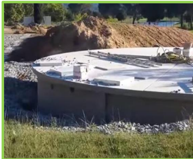
Figura 19: Reservorio enterrado
