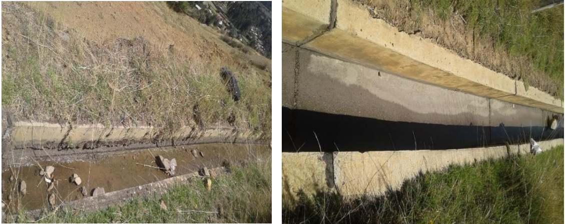
Vista de las juntas de construcción en tramos de 3m aproximadamente del canal de riego Pinar Huacrajirca, tramo 0+520 y 0+920
