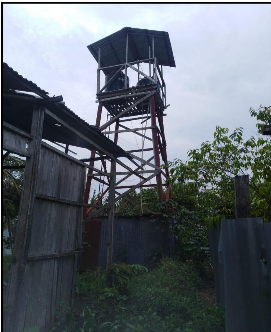
Figura 14. Tanque elevado conformado por castillo de madera, techo de calamina, cerco perimétrico de calamina y 2 tanques de almacenamiento.
