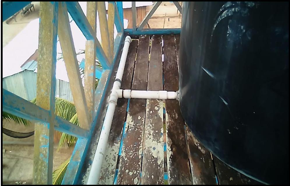
Figura 15. Tubería de aducción comprendida desde el reservorio (tanque de almacenamiento) hasta la red de distribución.
