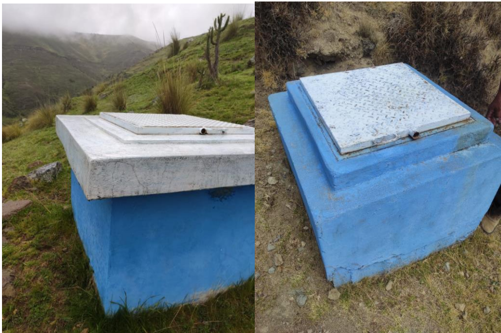
Figura N° 018: Cámara Rompe presión
