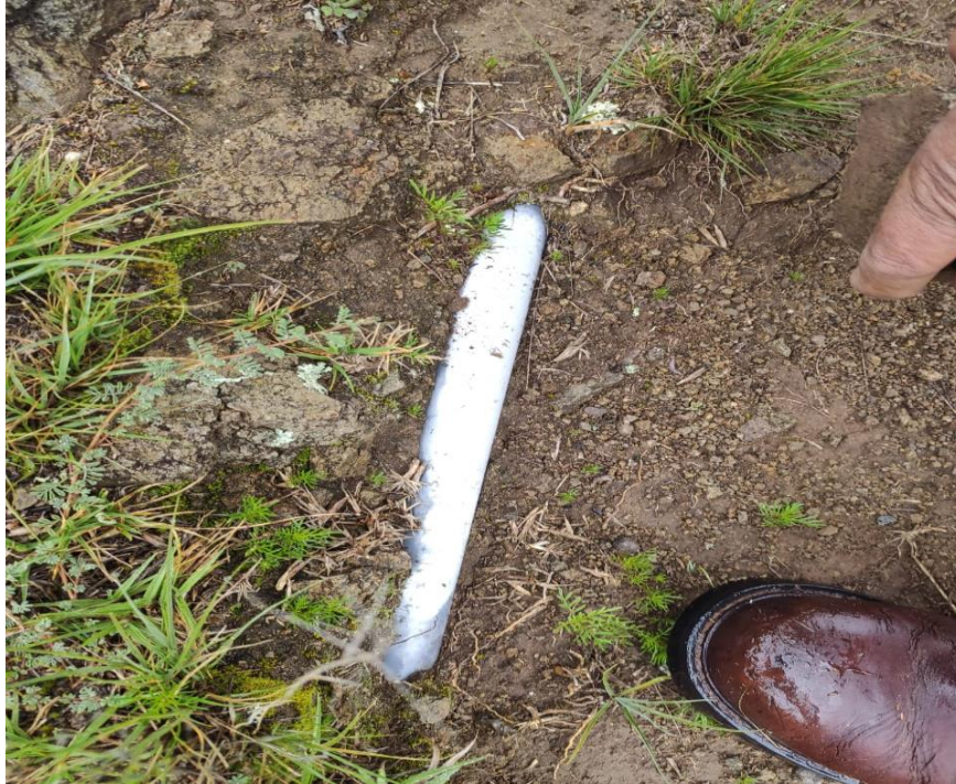
Fotografía N° 011: PARTES DE LAS VÍAS DE CONDUCCIÓN EXPUESTAS
