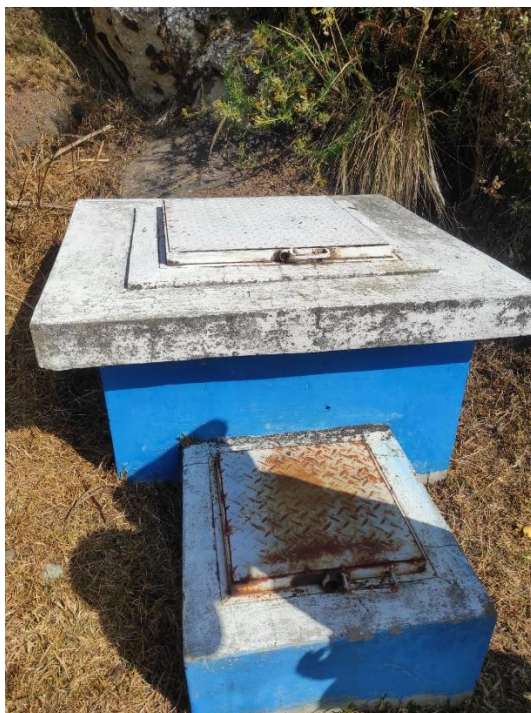
Figura N° 013: Cámara de captación (Ichiq ollque Cuya 02)
