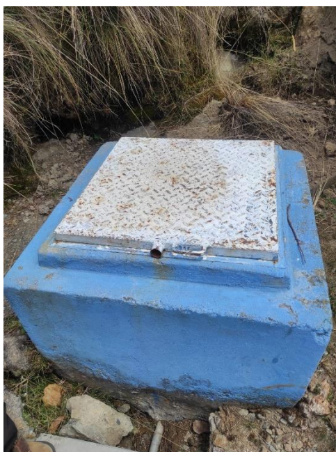
Figura N° 016: Cámara de Captación (Chequia Cuya 02)
