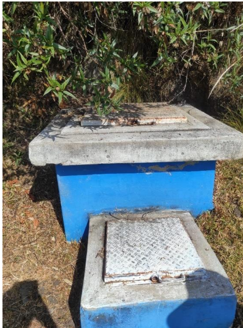
Figura N° 012: Cámara de Captación (Ichiq ollque Cuya 01)
