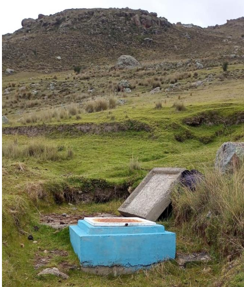
Figura N° 015: Cámara de Captación (Chequia Cuya 01)
