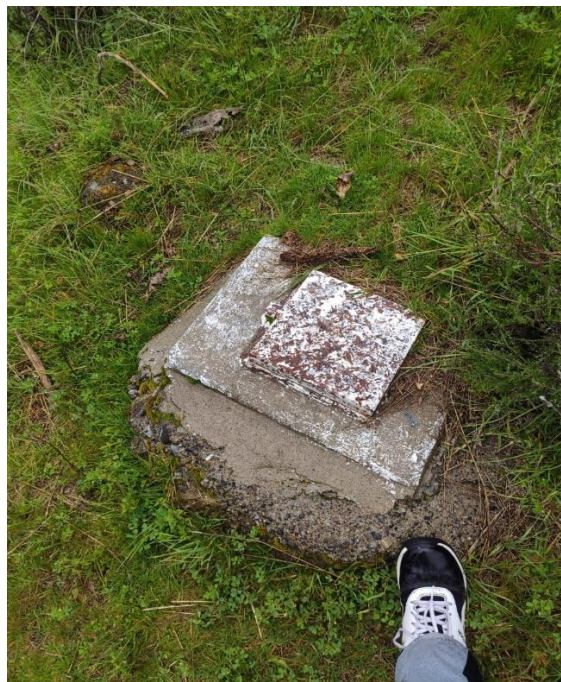
Fotografía N° 012: VÁLVULA DE AIRE
