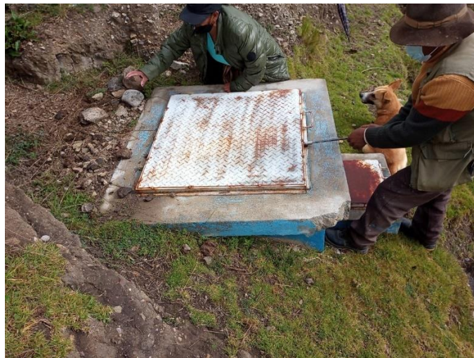
Figura N° 014: Cámara de Captación (Ichiq ollque cuya 03)
