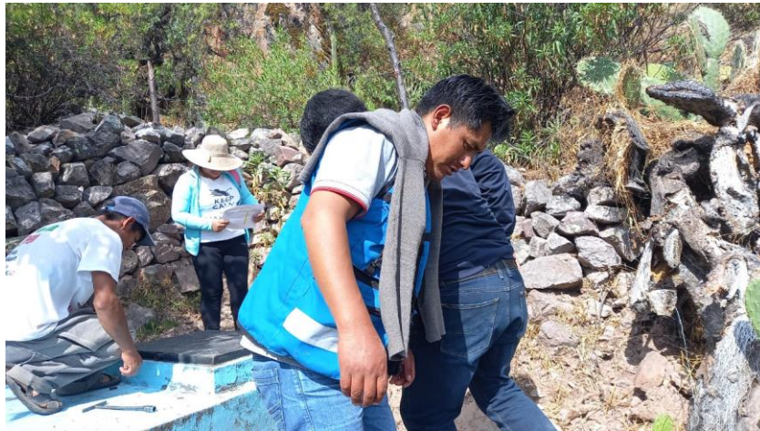
Figura 15: cámara de captación
