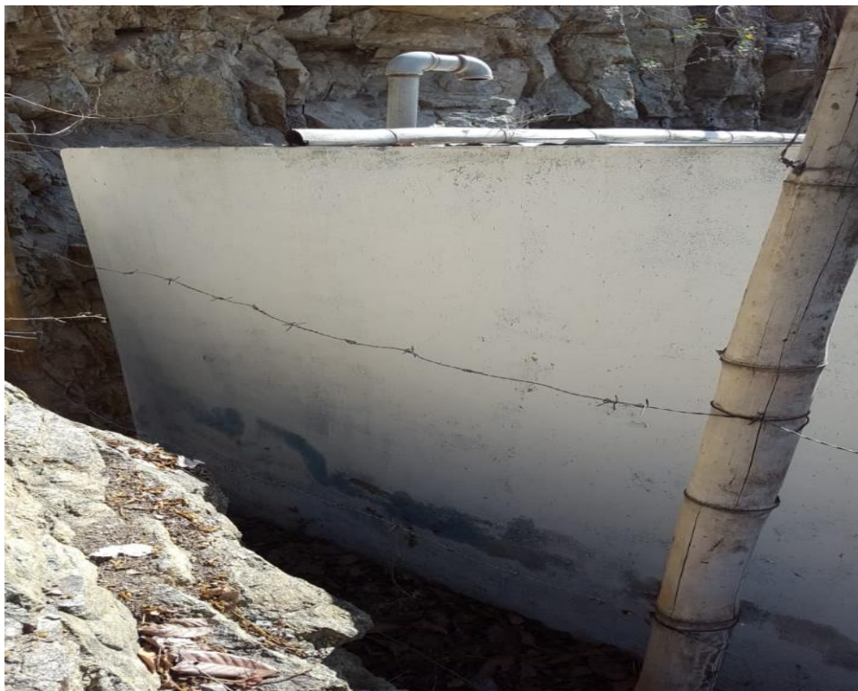
FOTO N° 6: CERCO PERIMETRICO DEL RESERVORIO
