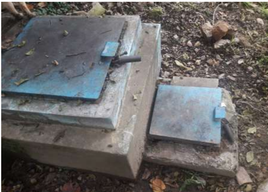
Figura 5. Cámara de captación vista en planta
