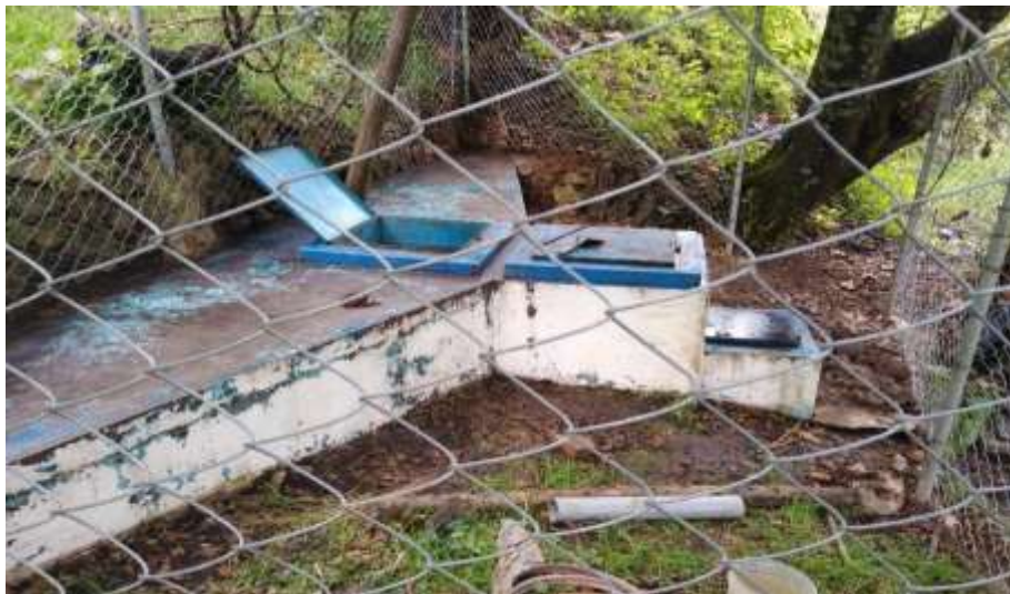
Figura 4. Cámara de Captación
