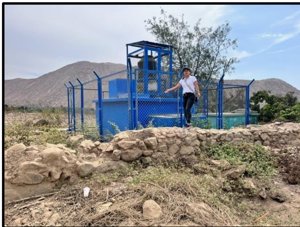
Figura 04: Cerco perimétrico del Reservorio.
