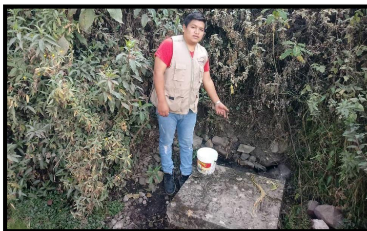
Imagen 1. Vista fotografía de la captación.
