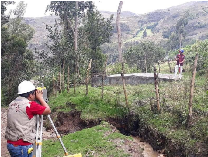
Fotografía 1: Levantamiento topográfico del Reservorio.
