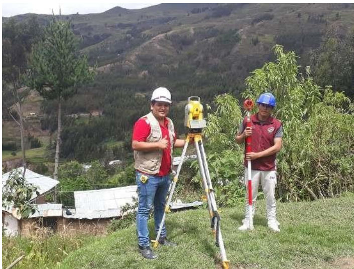
Fotografía 3: Trabajos de recolección de datos (Topografía)
