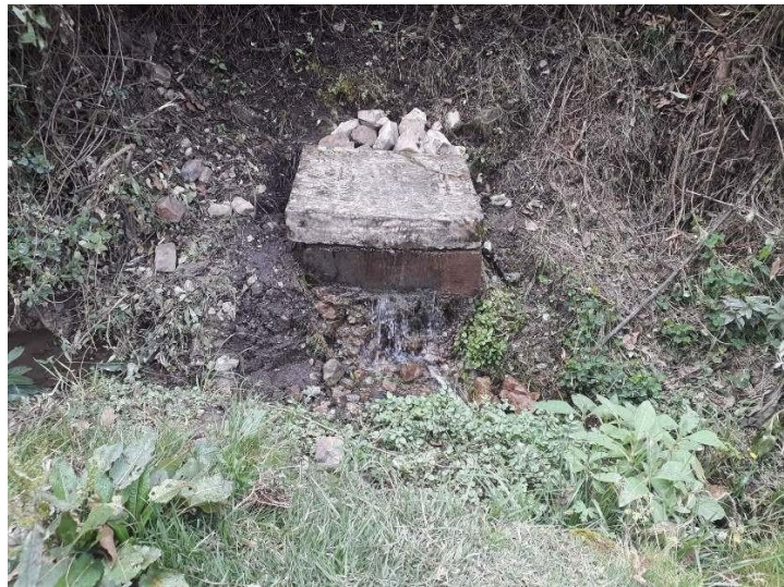
Fotografía 2: Vista de la captación.
