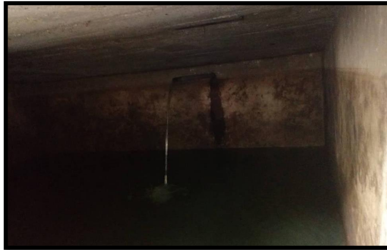
Imagen 6. Vista interna del Reservorio de almacenamiento.
