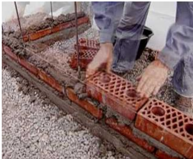
Imagen N° 02: Albañilería armada.
