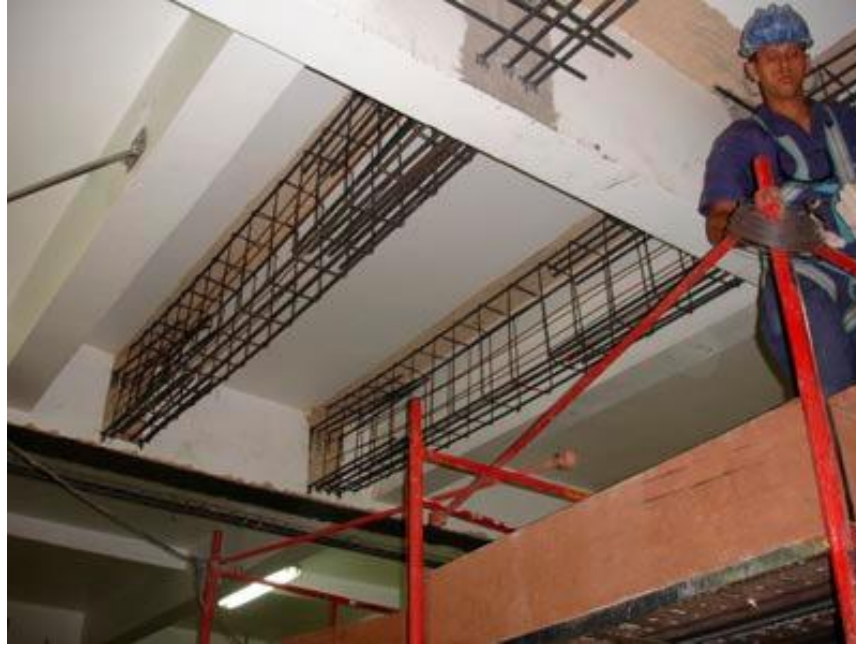
Imagen 05: Viga de concreto.
