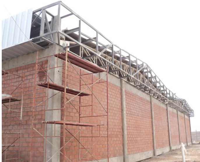
Imagen N° 03: Albañilería confinada.
