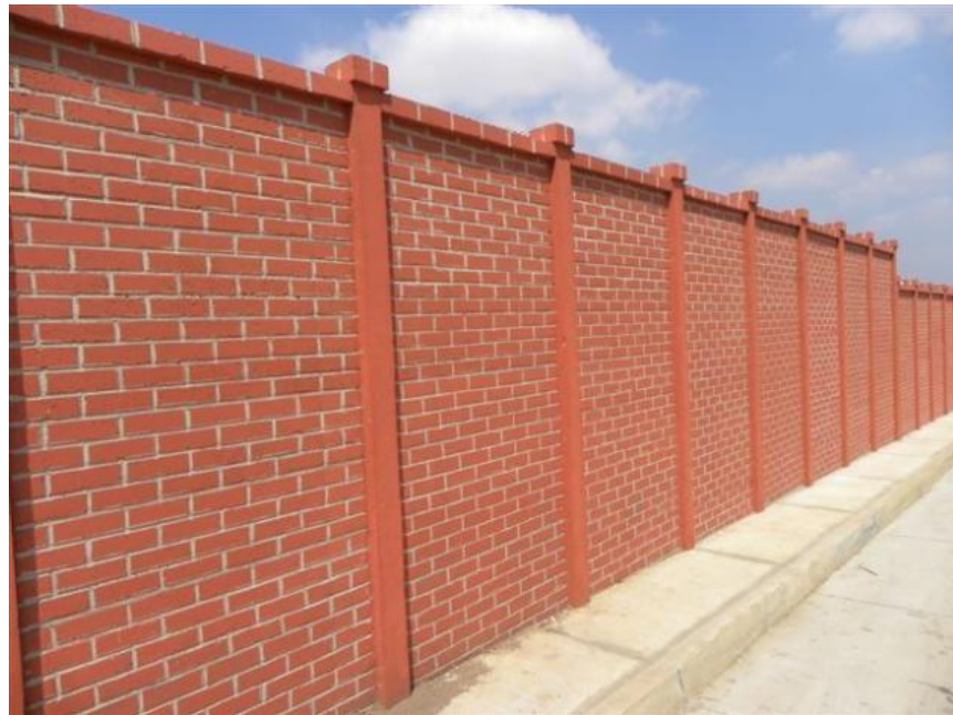
Imagen 09: Muro no portante.
