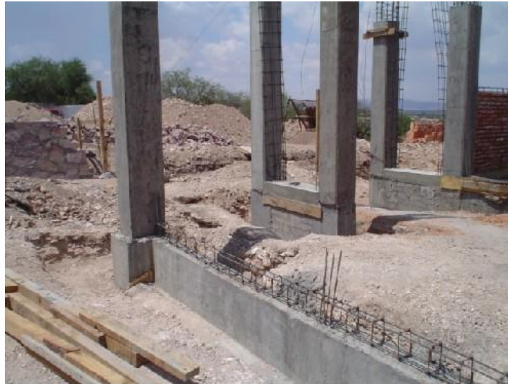
Imagen N° 04: Columna de concreto.
