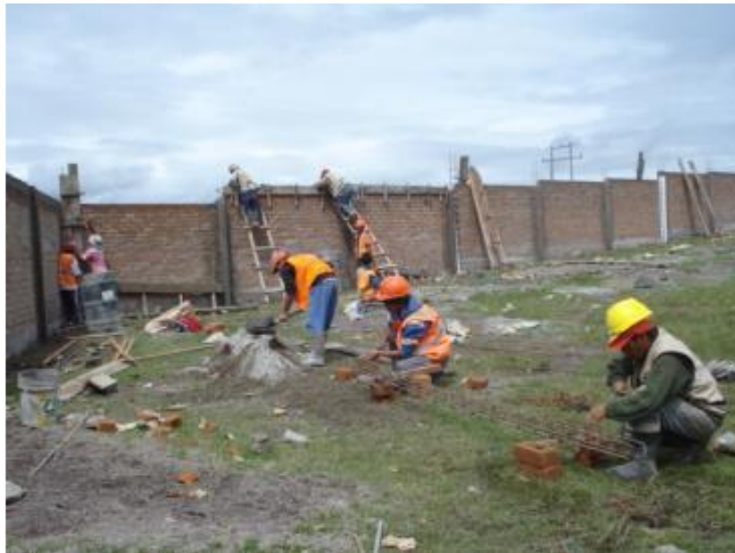
Imagen 07: Muro de albañilería.
