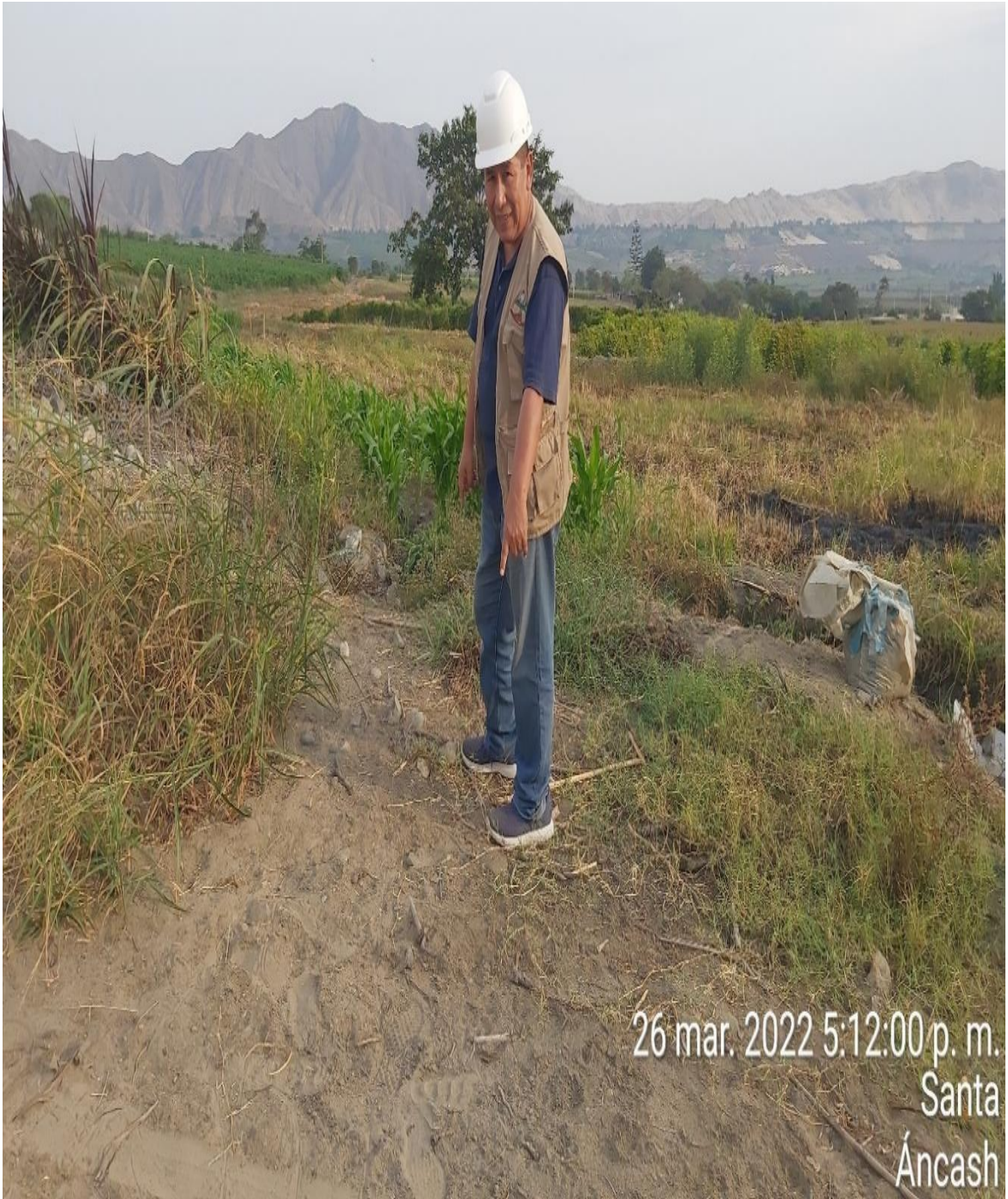
Figura 26: línea de aducción
