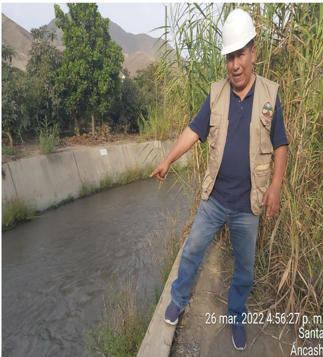
Figura 22: captación del sistema de abastecimiento
