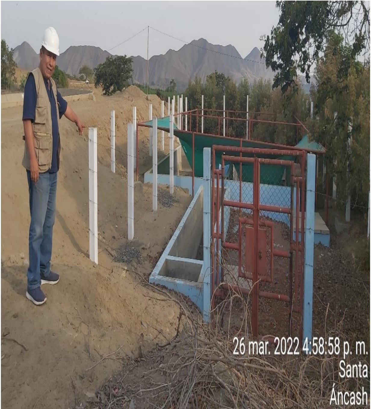
Figura 24: planta de tratamiento
