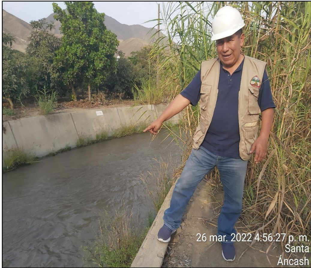
Figura 1: Captación sistema abastecimiento de agua Valle el Progreso
