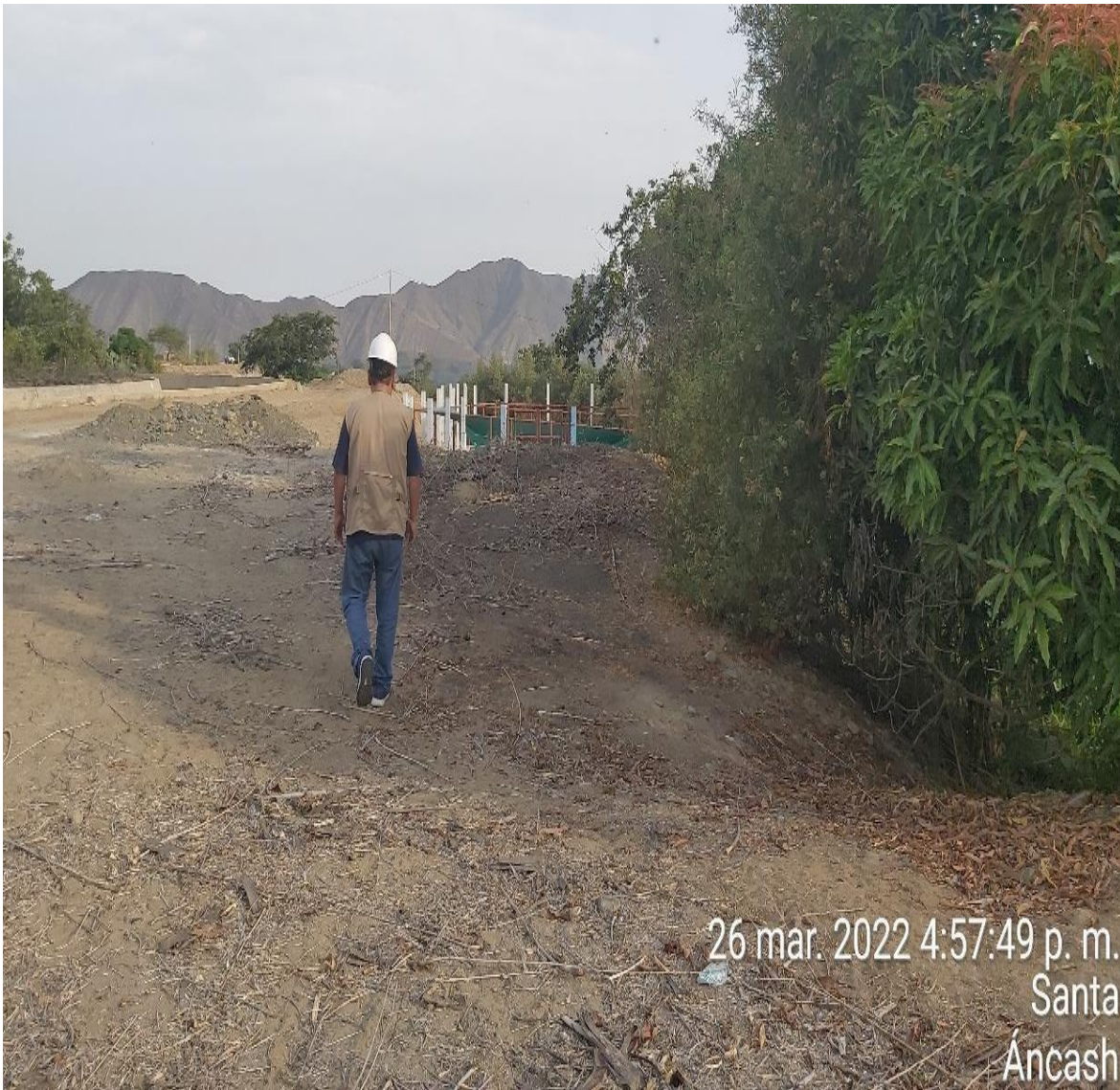
Figura 23: línea de conducción
