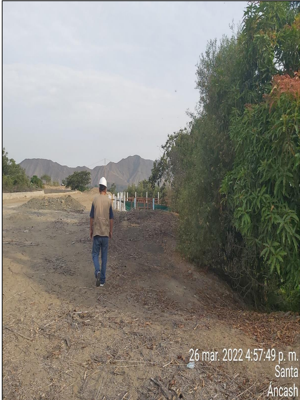
Figura 2: Línea de conducción sistema abastecimiento de agua CP El Progreso
