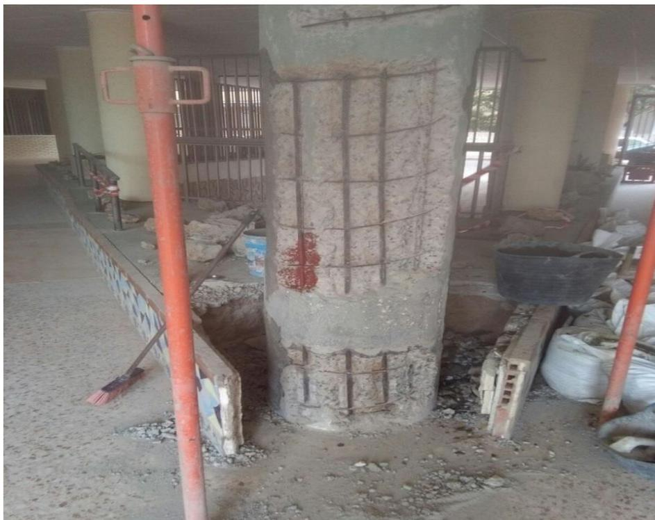
Gráfico 38. Recubrimiento inadecuado en pilar, exposición del acero de refuerzo. Edificio el Coloso. Fuente:
