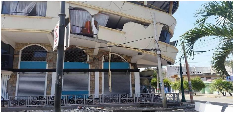
Gráfico 33. Vibración excesiva en edificaciones
