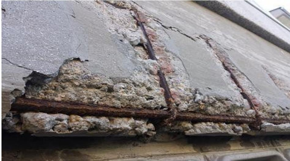
Gráfico 42. Corrosión de armadura en viga. Fuente:
