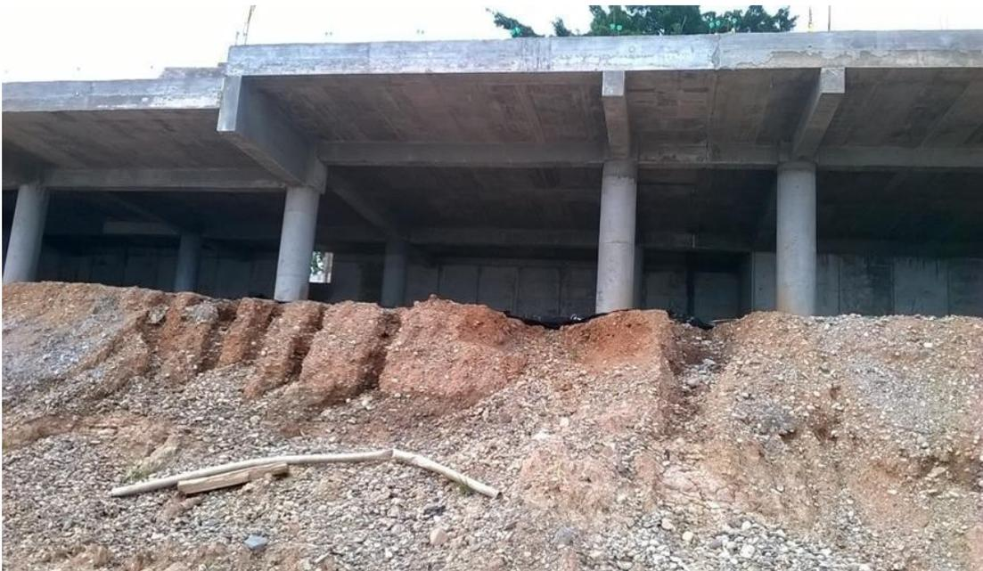
Gráfico: 90 Socavación de pilotes y pilares (Muelle malecón). Fuente: Propia
