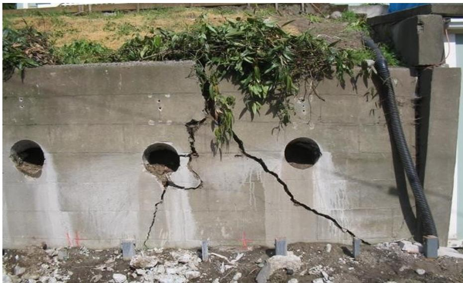
Gráfico 32. Volcamiento por fisuración excesiva
