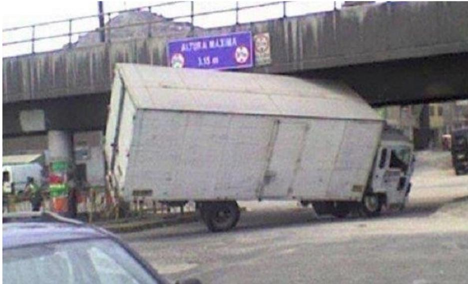
Gráfico 44.: Puente dañado por impacto de camión. Fuente:
