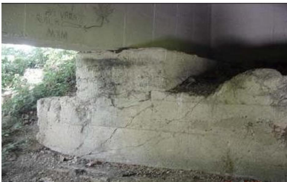
Gráfico 29. Fracturas por aplastamiento en la viga de cimentación. Puente: Palenquillo, Sucre. Fuente: (INVIAS, 2006)
