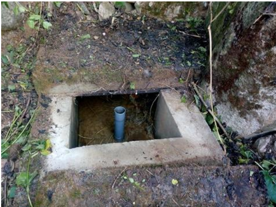
Figura 17. Cámara de captación
