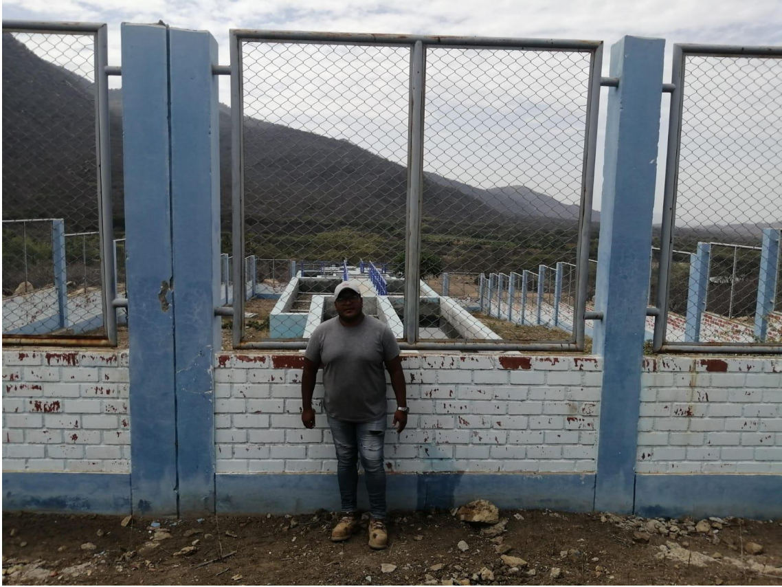
Imagen 8: Planta de Tratamiento del Caserio Cerro de Leones y San Pedro
