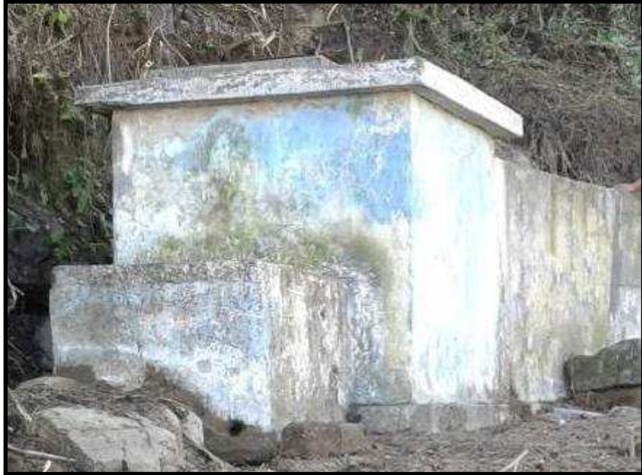
Imagen 1. Captación existente del Anexo Cashapampa.
