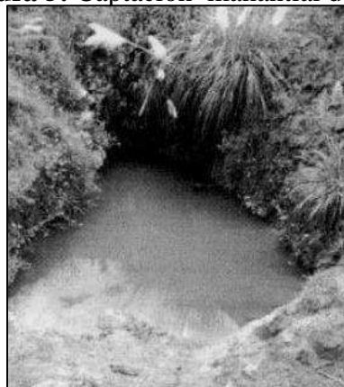
Figura 5: Captación manantial de ladera
