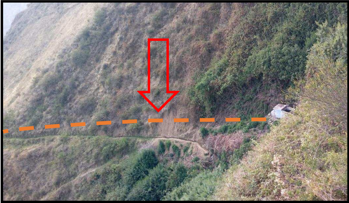
Imagen 2. Línea de Conducción.
