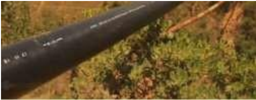
Figura 08. Línea de conducción
