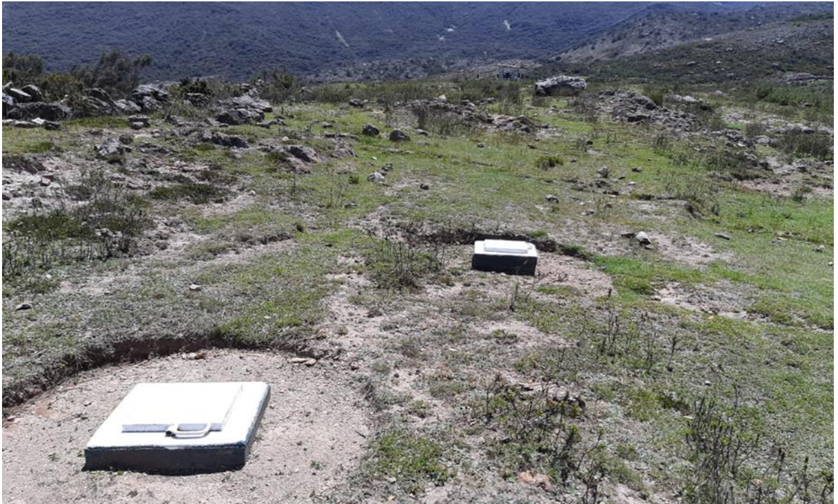
Fotografía 10 Cajas de inspección.
