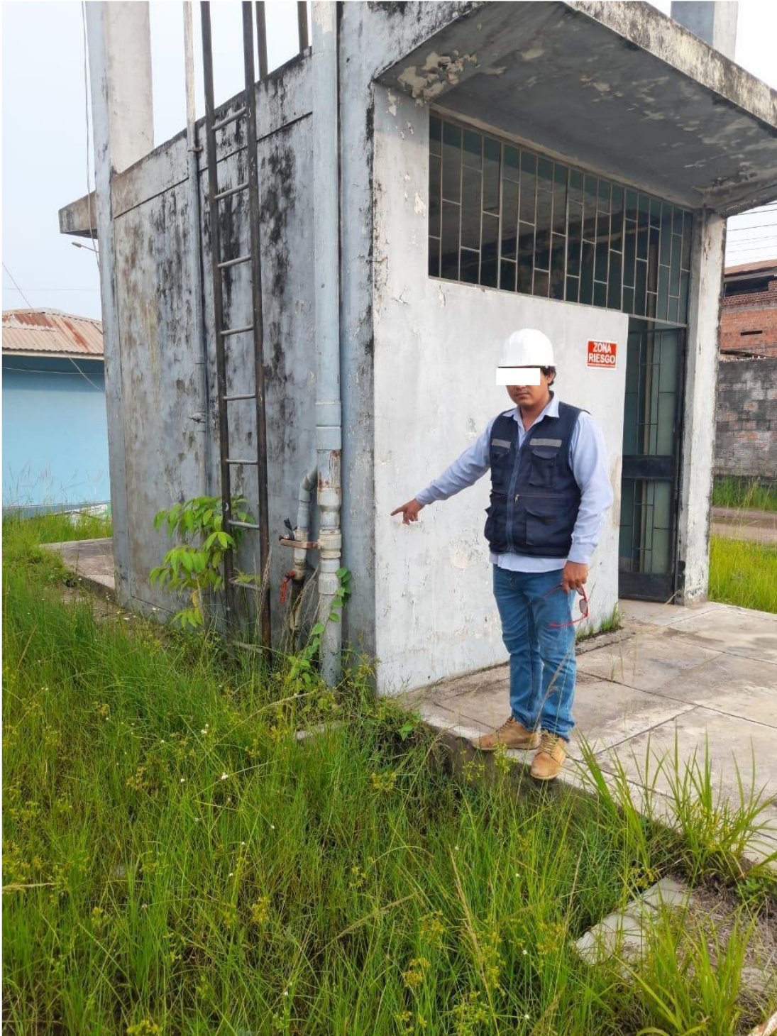
Imagen 20: Línea de aducción
