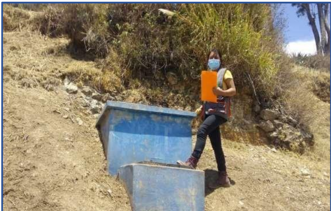
Fotografía N° 4. Evaluación de la estructura hidráulica.
