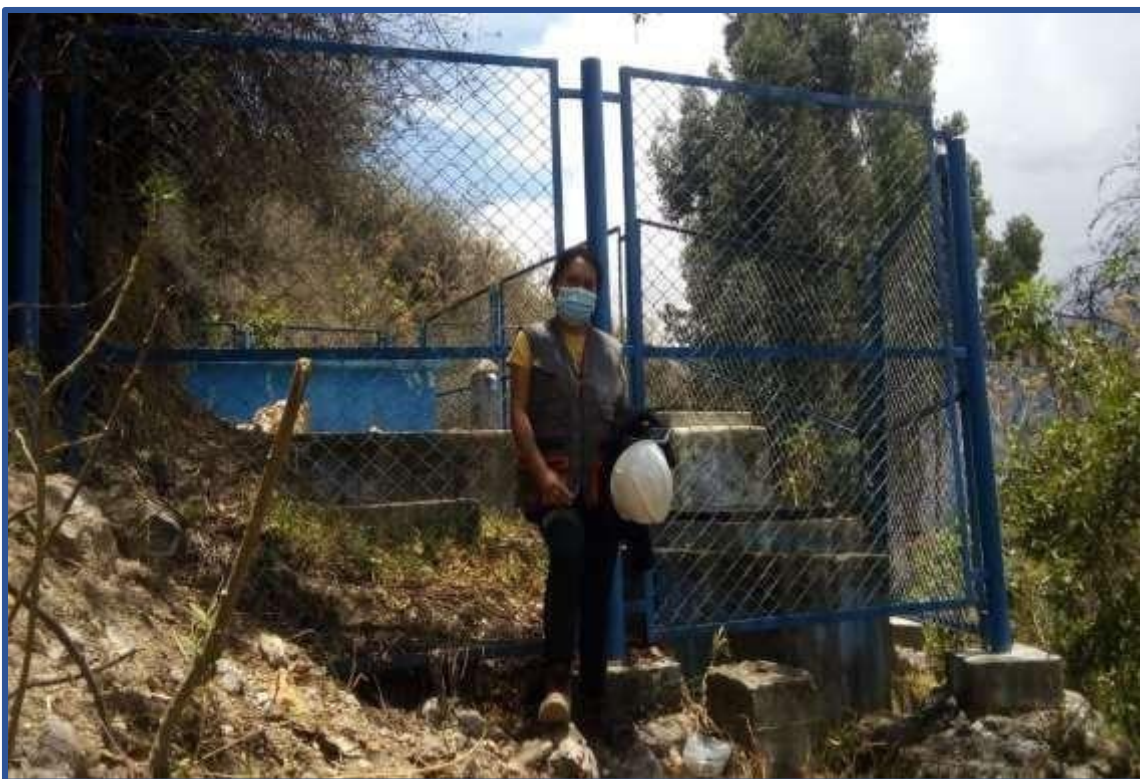
Fotografía N° 5. Vista del reservorio.
