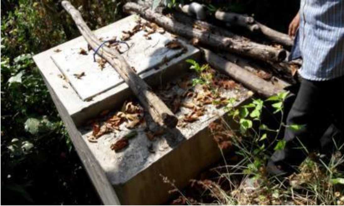
Imagen 2. Cámara de captación del caserío Villa La Mercedes, distrito de Moro, provincia del Santa, departamento de Ancash.
