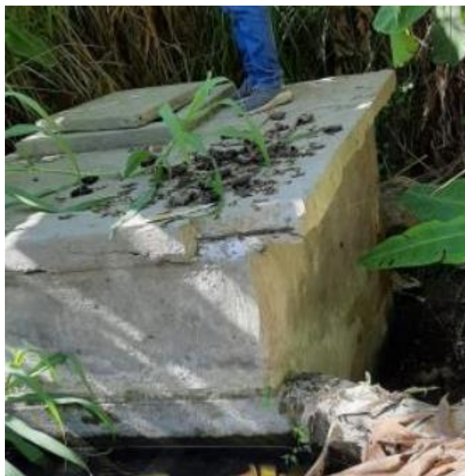
Imágen 1 Obra de captación por manantial tipo ladera de localidad San Isidro
