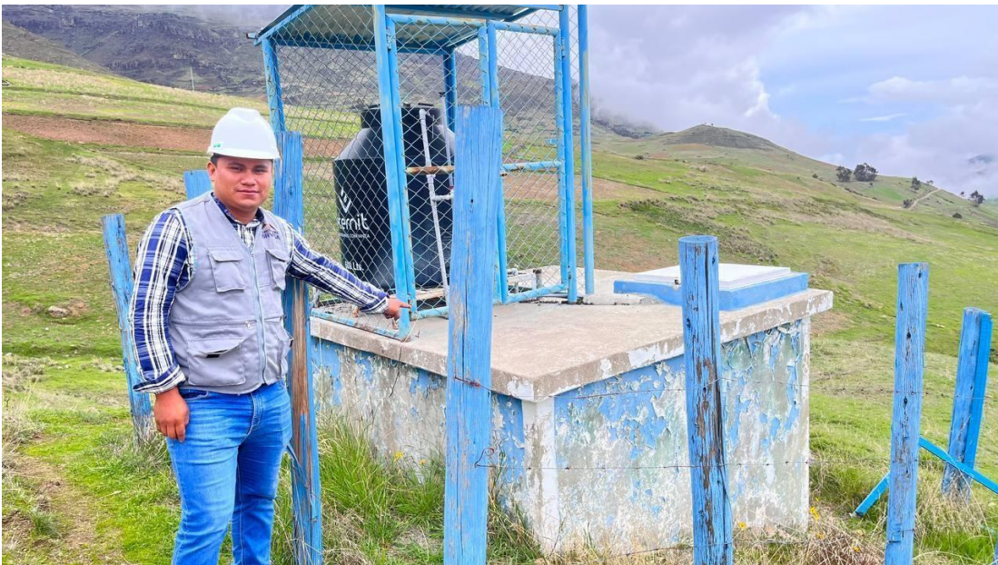
Imágen 7 Reservorio apoyado rectangular localidad San Isidro
