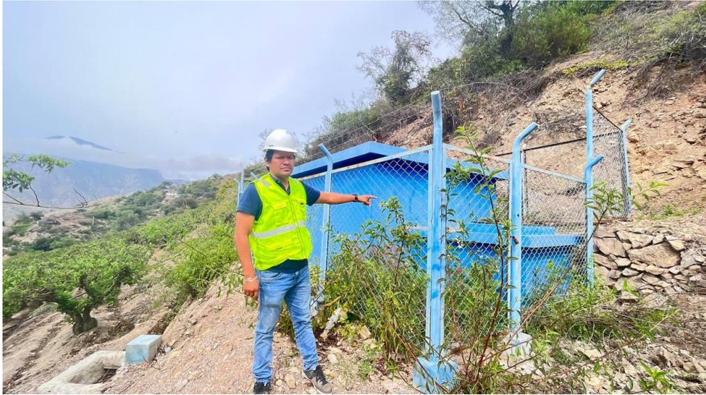
**Imagen 4** Reservorio existente apoyado de 10 m<sup>3</sup>
