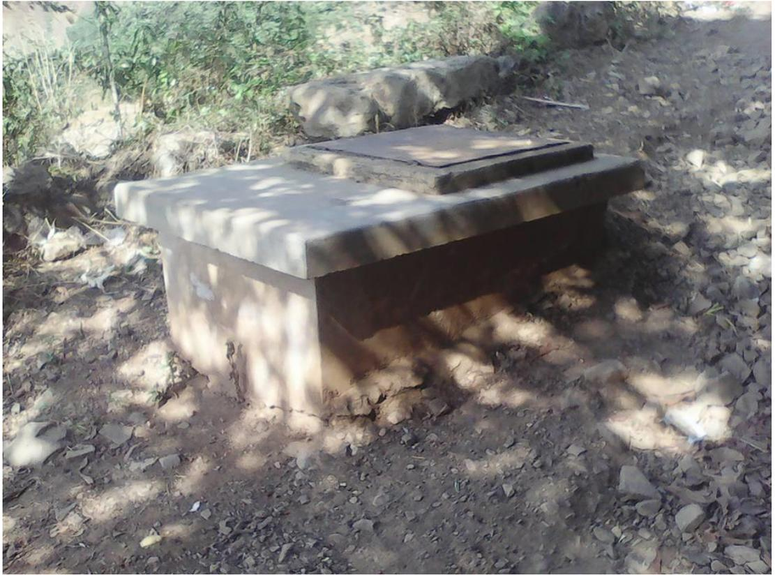
**Imagen 2** Cámara rompe presión tipo 6 sin pintar y sin cerco perimétrico
