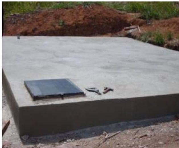
**Figura 11** Construcción de reservorio enterrado
