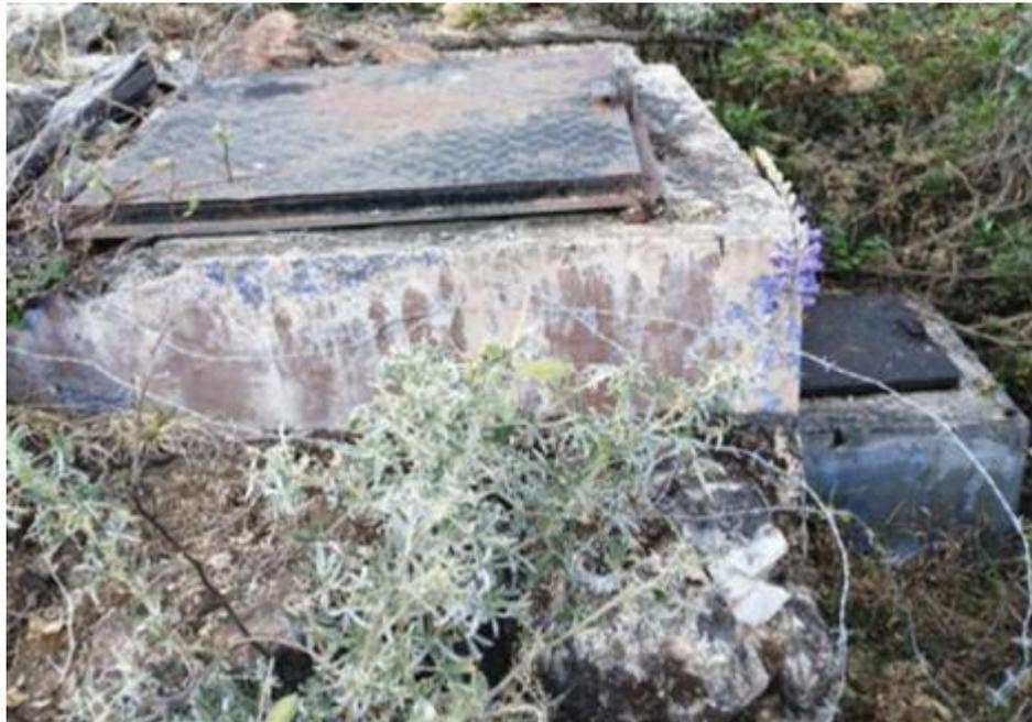
**Imágen 1** Captación de ladera deteriorado, pintura desprendida de las paredes
