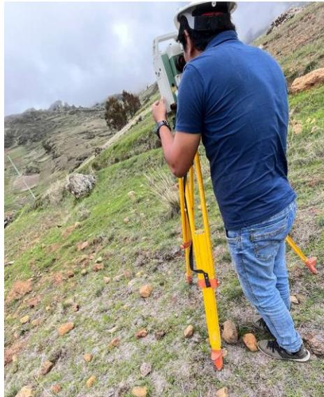
**Imágen 11** Levantamiento topográfico
