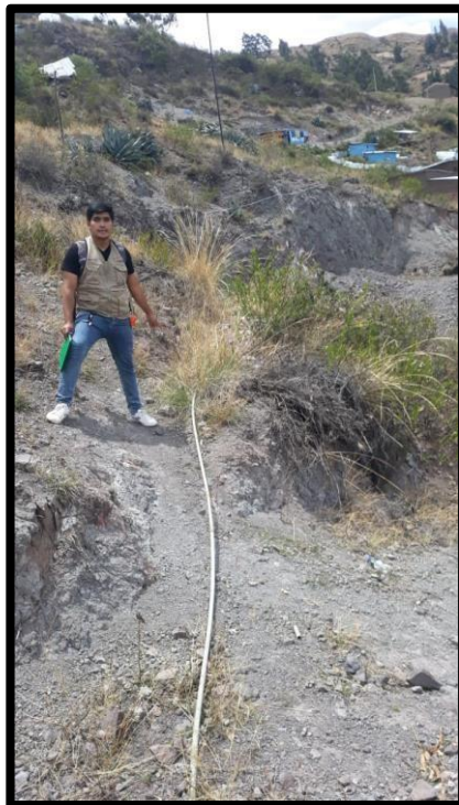
Imagen N° 02: Se puede observar que la Línea de conducción, una parte está al aire libre y la otra parte enterrada.
