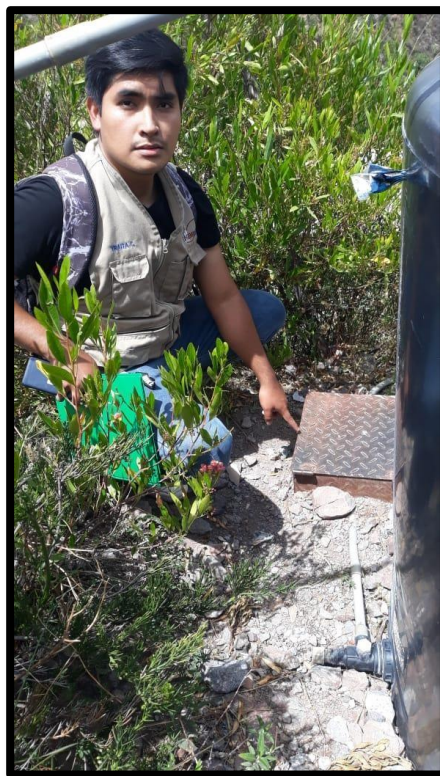
Imagen N°04: Se observa que la línea de conducción sale desde el tanque de almacenamiento, cuenta con una caja de válvula, donde va la llave de paso y cierta tubería se encuentra al aire libre.
