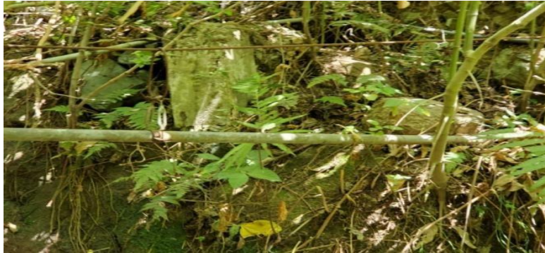
Pases aéreos (línea de conducción)
