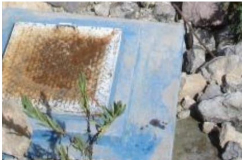
Fotografía 02: Cámara de captación existente
