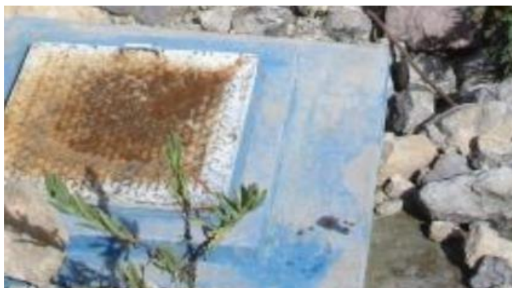
Gráfico 14. Cámara de captación de caracucho
