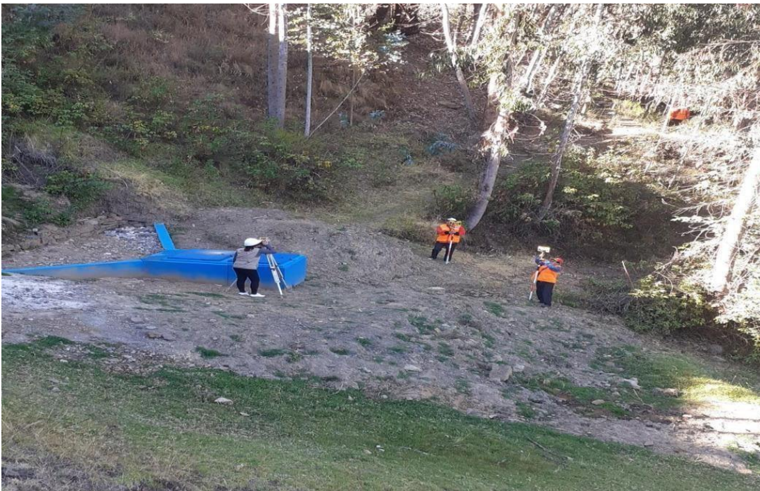
Imagen 15: La captación se encuentra en mal estado
