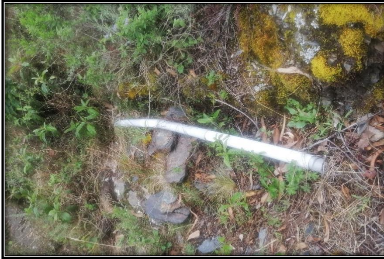
Fotografía 11: Tramo de la red de distribución descubierto.
