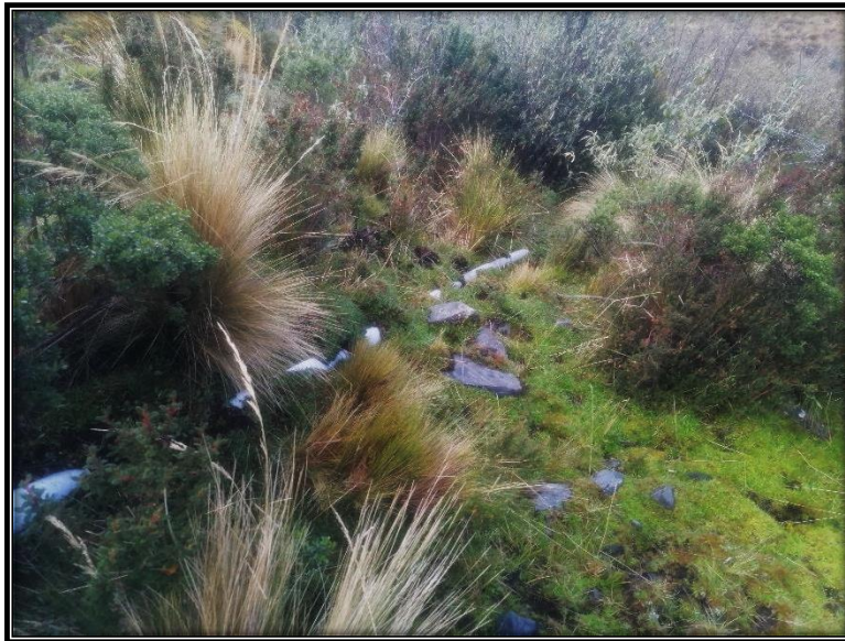
Fotografía 04: Verificación del estado actual de la línea de conducción.
