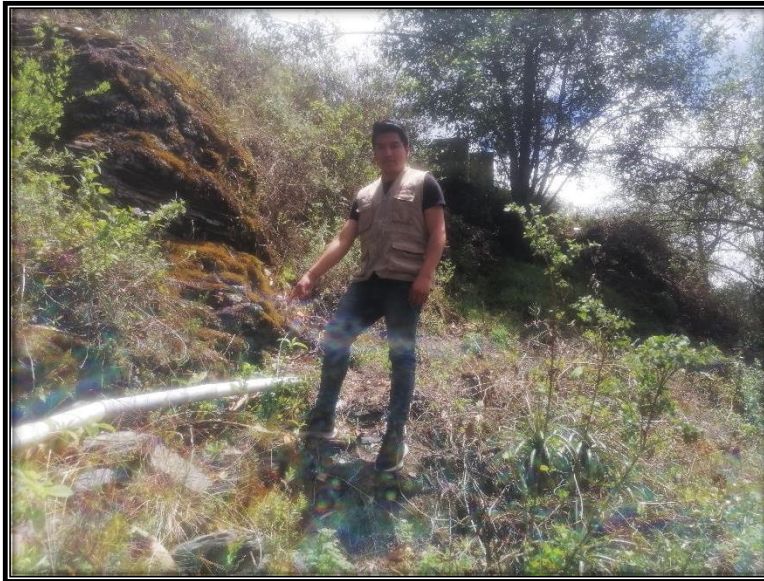
Fotografía 12: Verificación del tramo descubierto de la red de distribución
