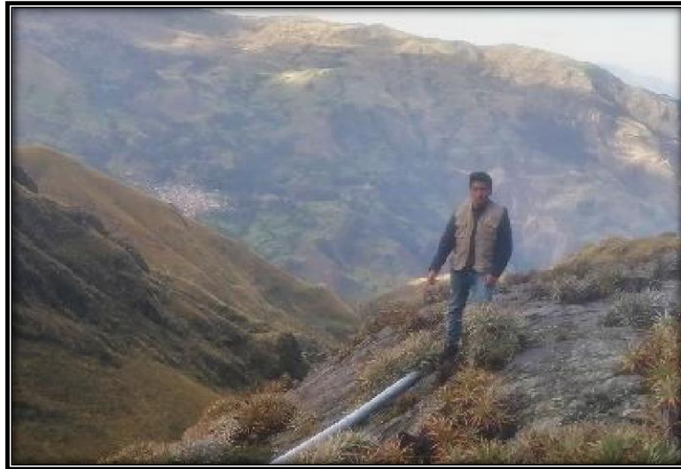
Fotografía 05: Estado actual de la línea de conducción, tramo no enterrado.
