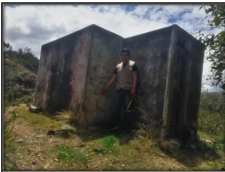
Fotografía 10: Verificación del estado actual en que se encuentra el reservorio.
