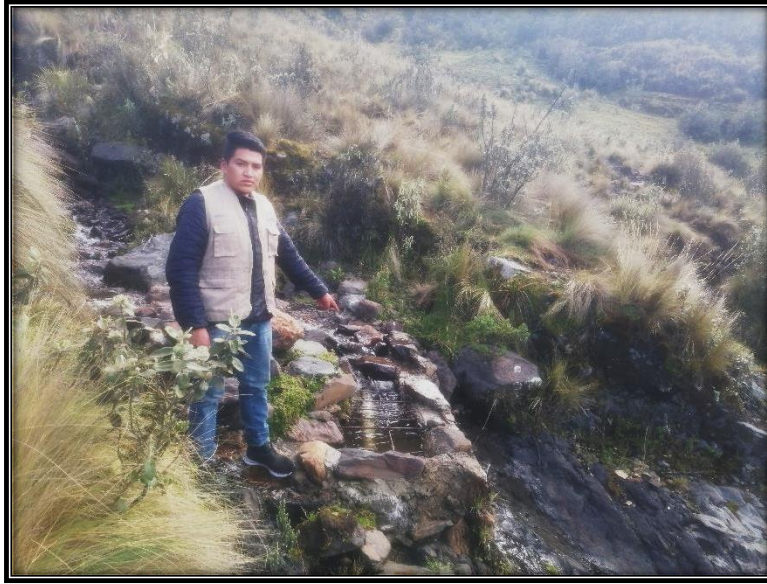
Fotografía 03: Verificación del estado actual de la captación.
