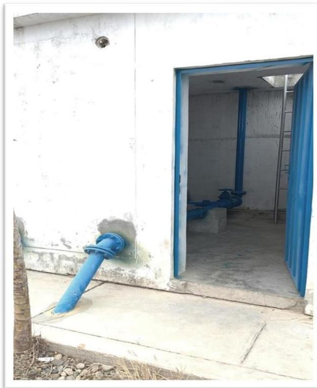
**Figura 9.** Tubería de Impulsión
