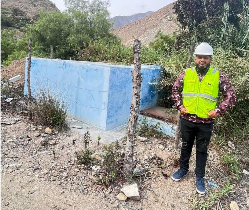
**Imágen 4** Reservorio apoyado rectangular  $v=10m^3$  deteriorada, sin cerco perimétrico metálico y sin sistema de desinfección del agua
