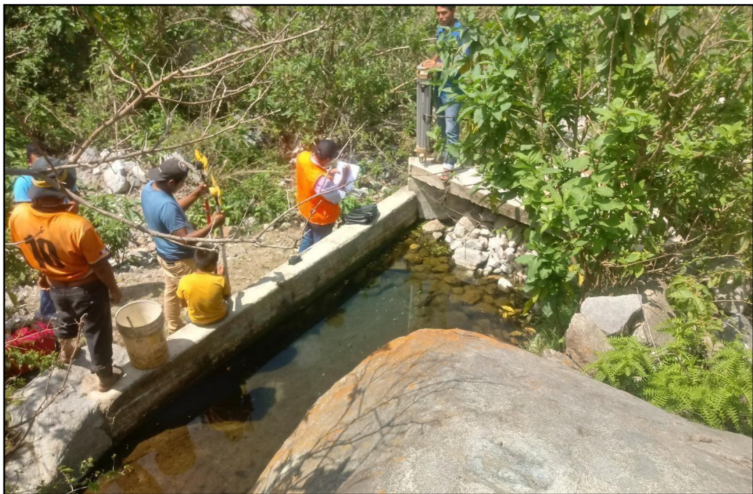
Imagen 2: Toma de puntos topográfico en la captación de Tanin
