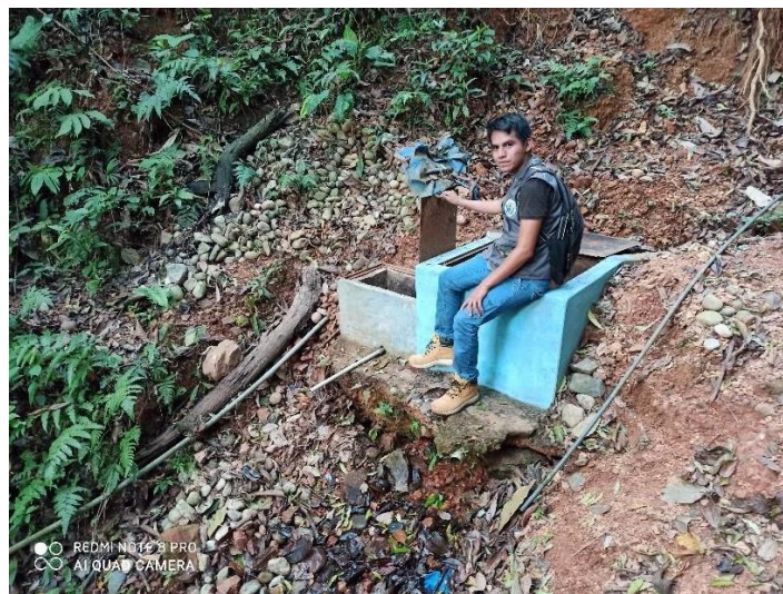
Figura 21 Inspección de Captación
