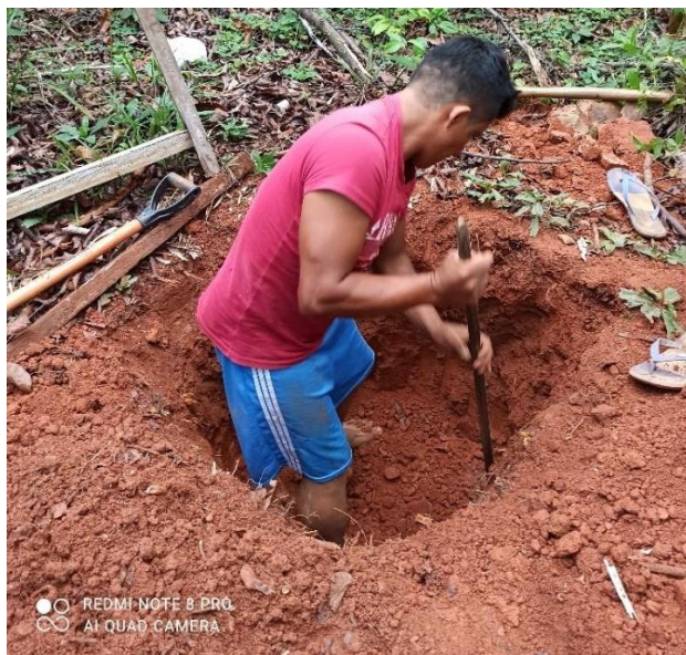
Figura 25 Excavación de Calicata para Muestra de Suelo
