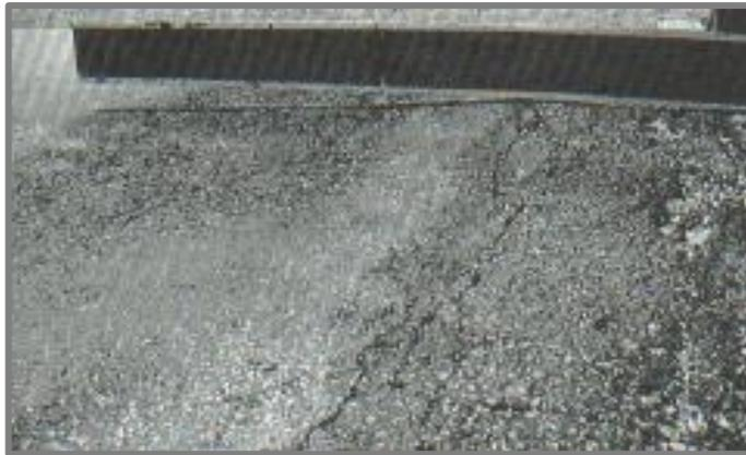
**Imagen 4. Abultamiento y hundimiento de alta severidad**
