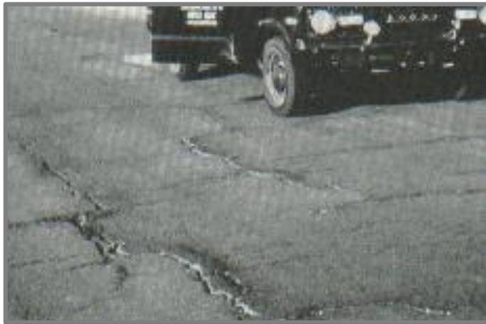
**Imagen 3. Agrietamiento en bloque de alta severidad**
