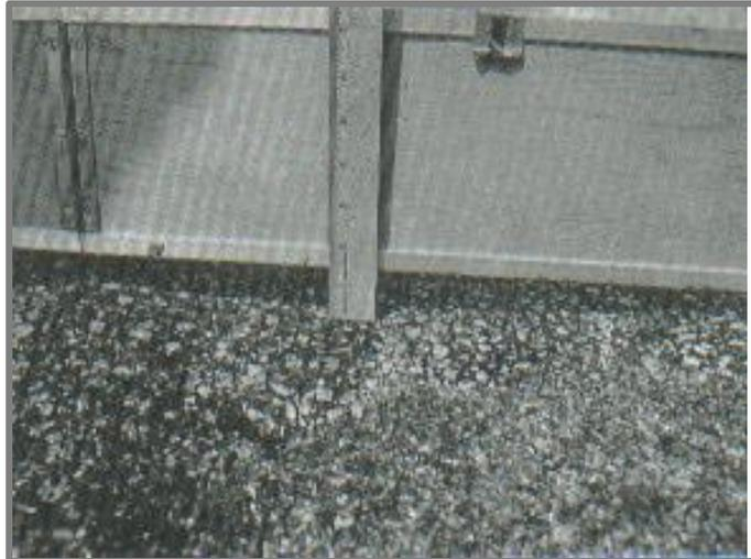
**Imagen 15. Ahuellamiento de alta severidad**
