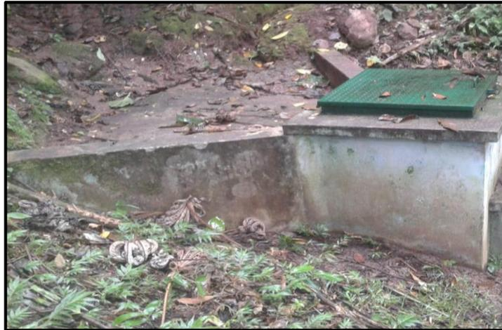
**Figura 1:** Captación de manantial tipo ladera existente
