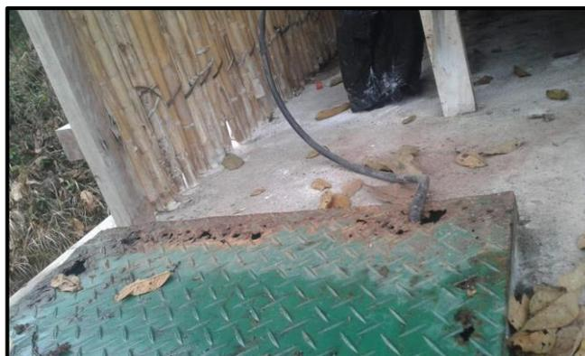
**Figura 3:** Tapa sanitaria del reservorio existente
