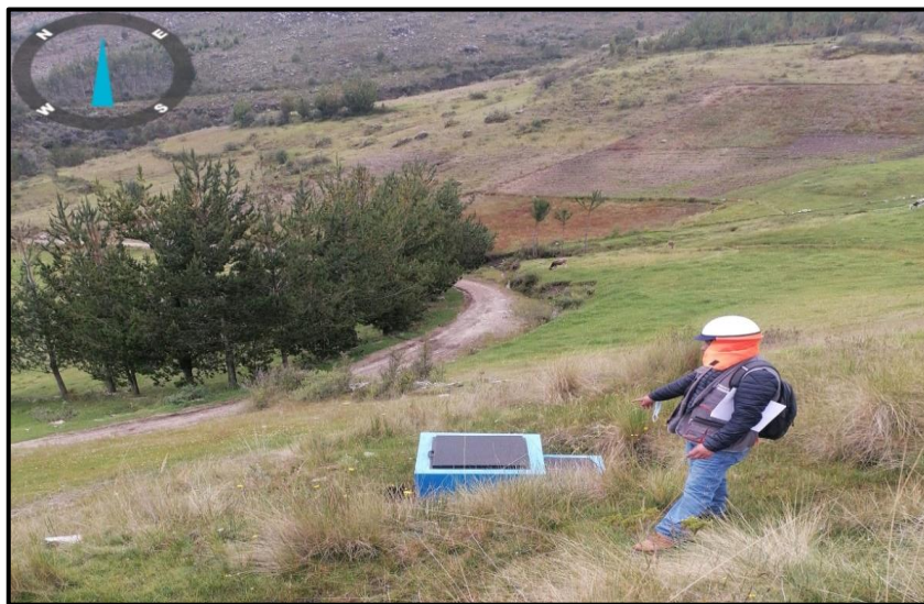
Figura 26: Cámara rompe presión
