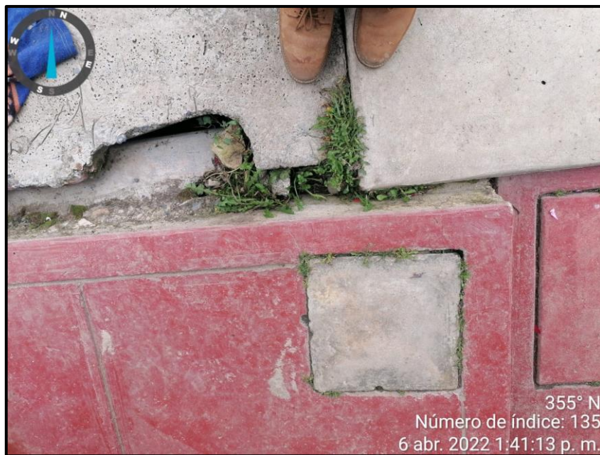
Figura 28: Conexiones domiciliarias del caserío de Pumahuasi
