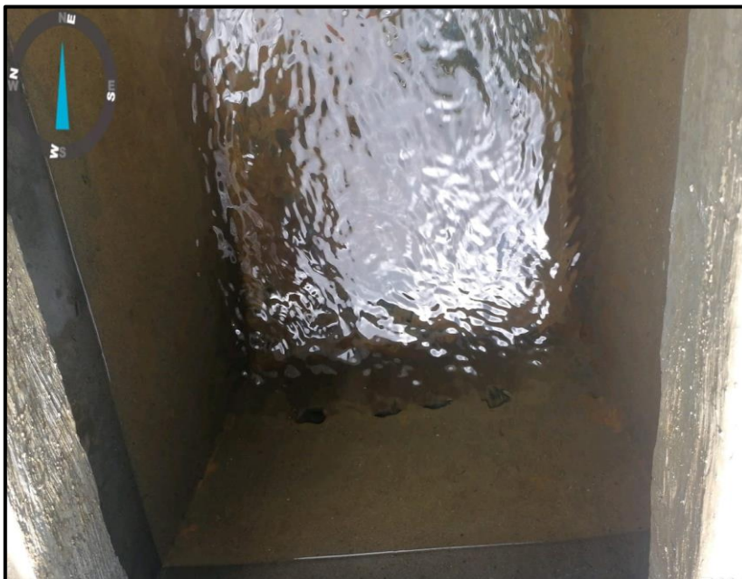
Figura 24: Interior de la cámara húmeda
