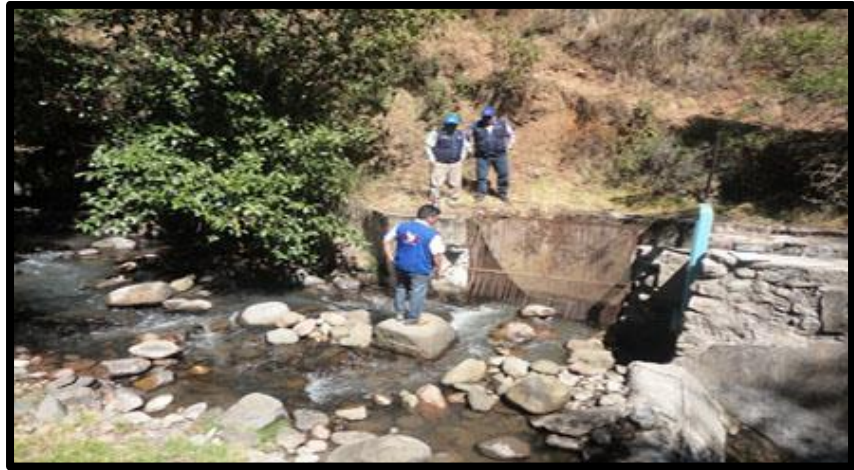
Figura 1: Estructura hidráulica de Captación para aguas superficiales Fuente: Extraído del portal web Defensoría del Pueblo.
