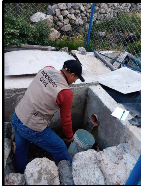
Figura 3: Medida de caudal método volumétrico Fuente: Toma fotográfica propia 2023.
