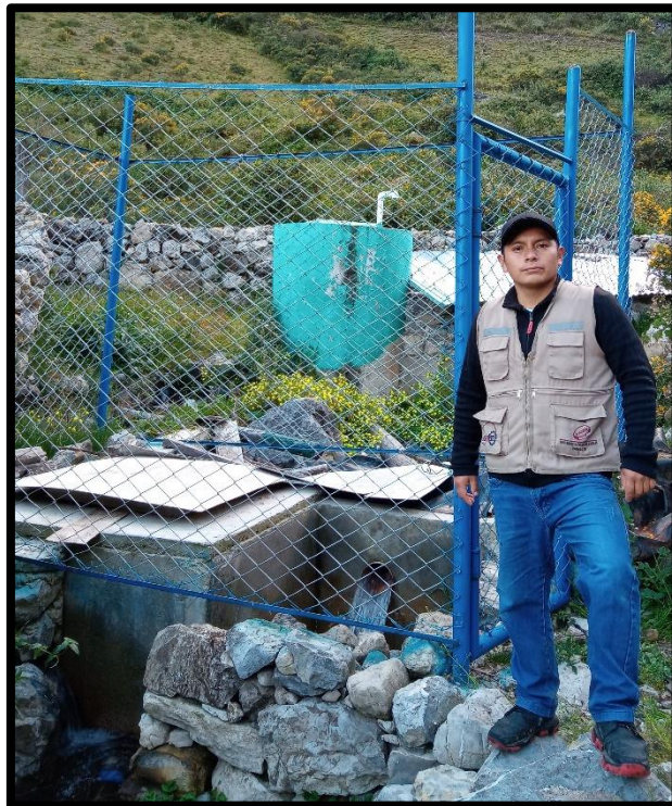
Figura 28: Visita a la captación caserío santa rosa de Huashla Fuente: Toma fotográfica propia 2023
