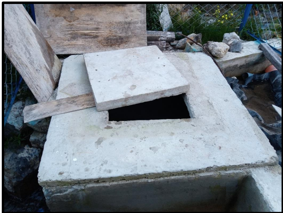
Figura 26: Exterior cámara húmeda caserío santa rosa de Huashla Fuente: Toma fotográfica propia 2023
