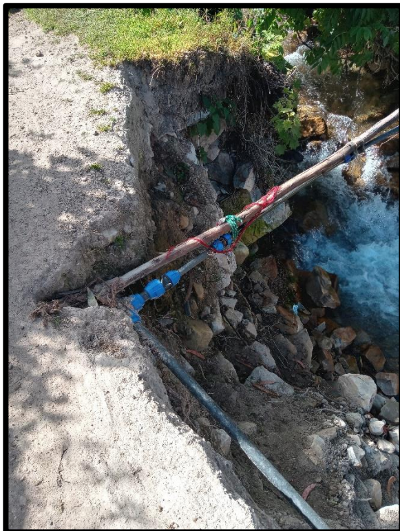
Figura 37: Red de distribución caserío santa rosa de Huashla Fuente: Toma fotográfica propia 2023
