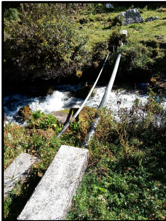
Figura 32: Pase aéreo caserío santa rosa de Huashla Fuente: Toma fotográfica propia 2023
