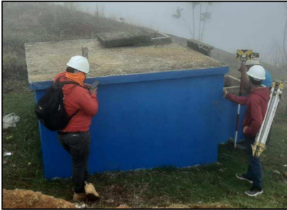
Figura 1: Reservorio existente del Anexo Chongos
