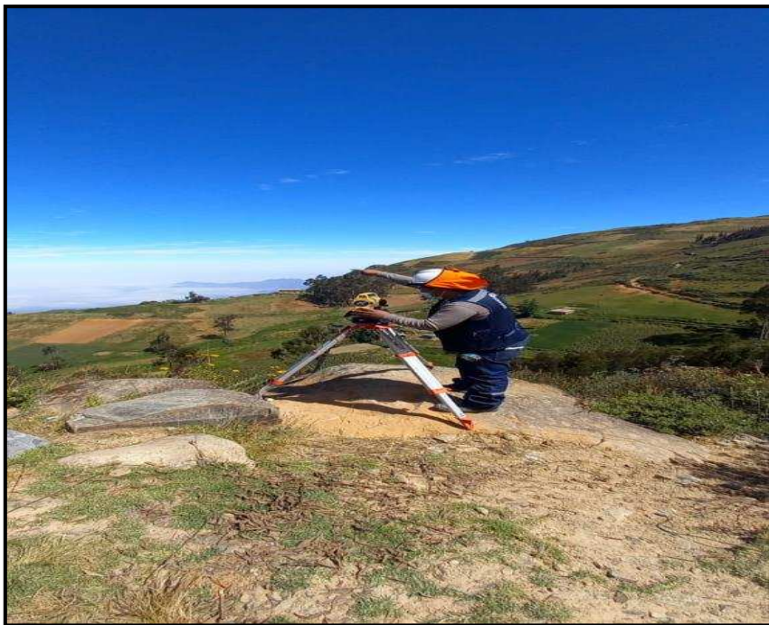
Figura 4: Levantamiento Topográfico para Sistema de Agua Potable.
