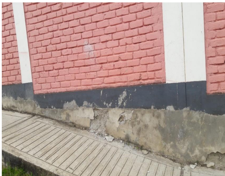
Gráfico 6: presencia de desprendimiento en sobrecimiento
