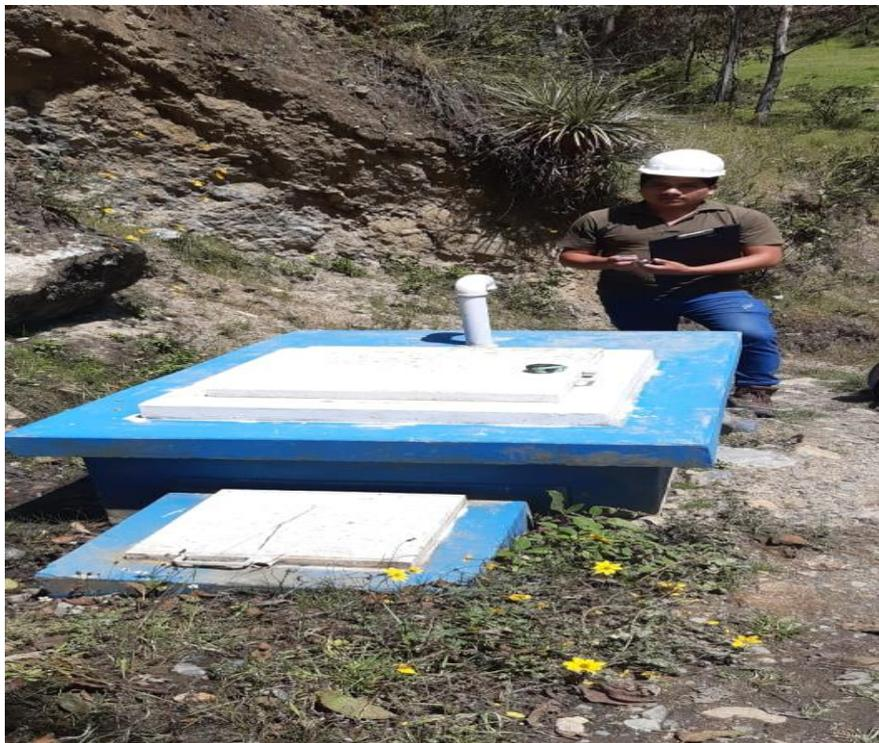
**Figura n° 19:** cámara rompe presión
