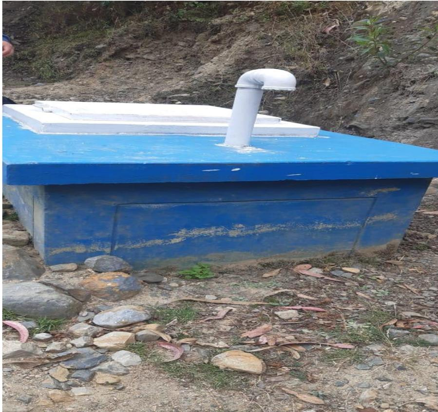
**Figura n° 18:** cámara rompe presión
