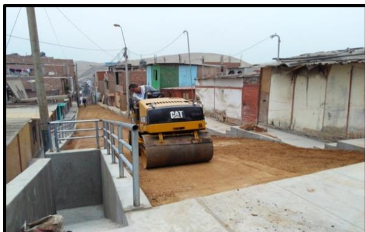
Figura_11 Compactación De Base
