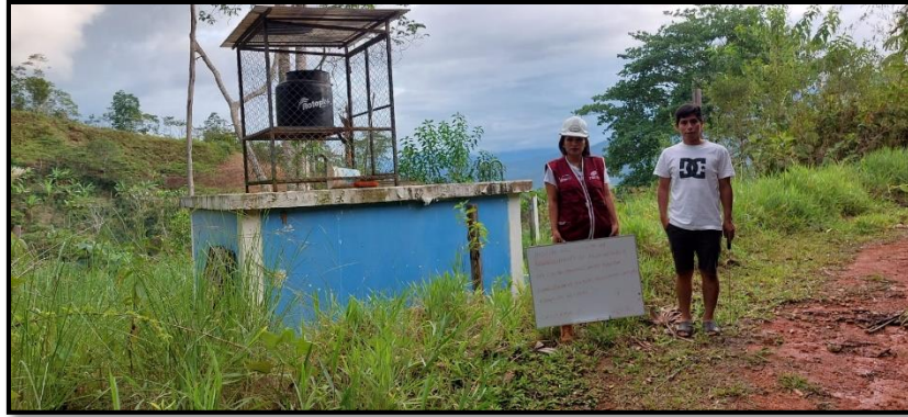
Figura 26: Reservorio existente de Alto Santa Clara Fuente: Elaboración propia
