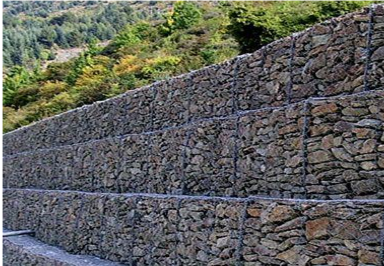
Figura N° 03. Gavion regularmente estructurados Fuente: Geotenia y fiscalización
