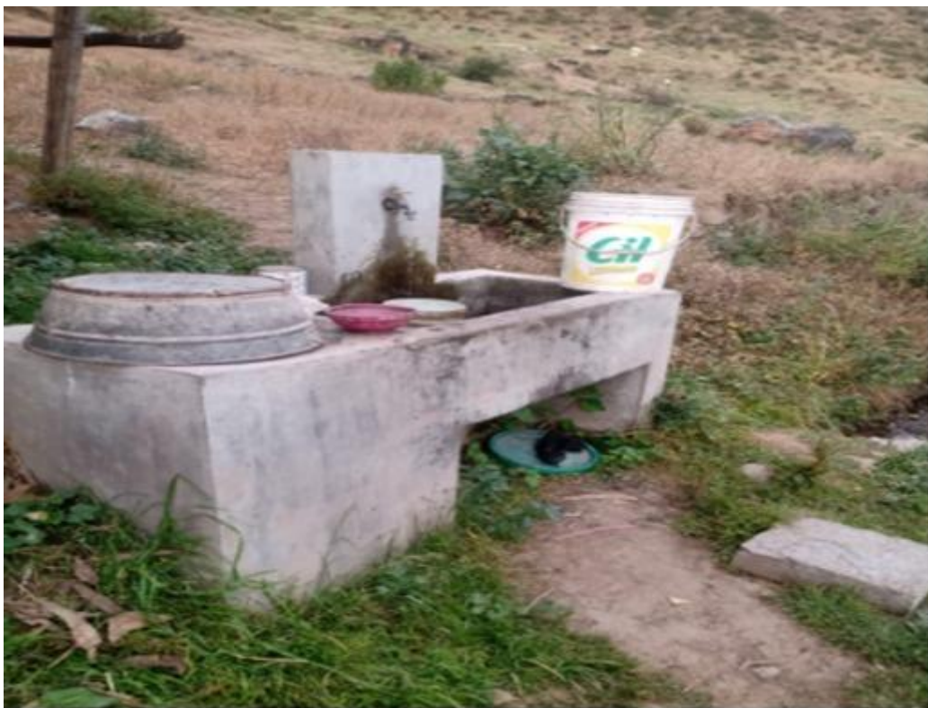
Figura 10: Lavadero del caserío de Parac
