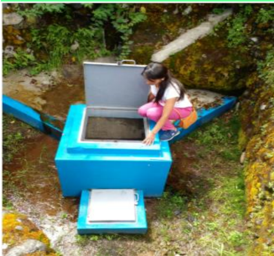
Figura 03: Interior de la Cámara Húmeda
