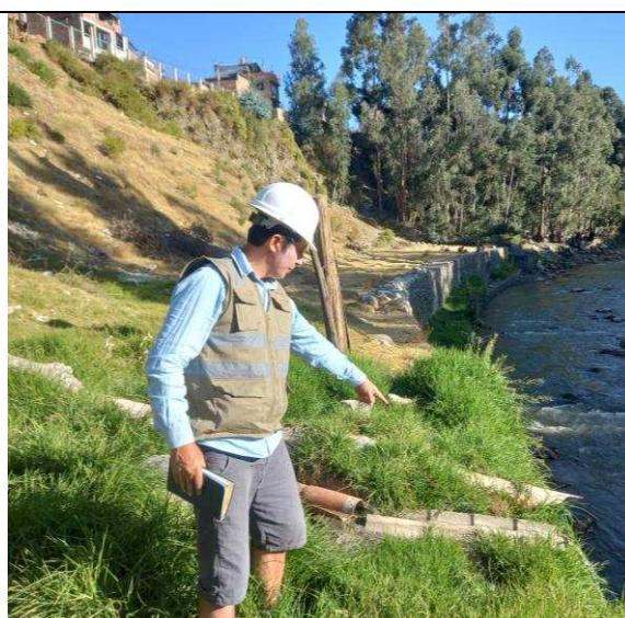
Foto N° 72: Vertimiento de aguas residuales (desagüe de la Urb. San Pedro), prog. 0+092.
