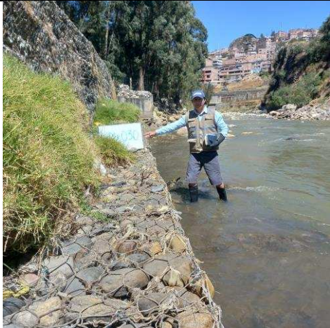
Foto N° 07: Nivel de agua y estado regular del colchón reno en el tramo 4.
