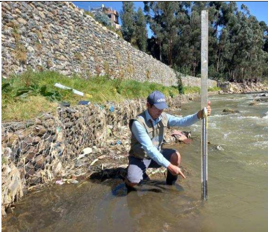
Foto N° 15: Nivel de agua, medición de la deflexión y socavación en el tramo 8.
