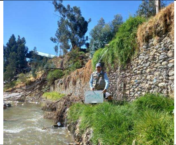
Foto N° 26: Nivel de agua, medición de la deflexión y socavación en el tramo 10.
