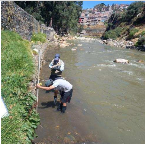
Foto N° 09: Nivel de agua y estado regular del colchón reno en el tramo 5.
