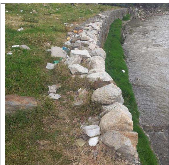
Foto N° 71: Acopio de rocas en la corona del muro, prog. 0+070-0+080.
