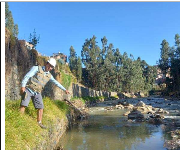
Foto N° 27: Nivel de agua, medición de la deflexión y socavación en el tramo 11.
