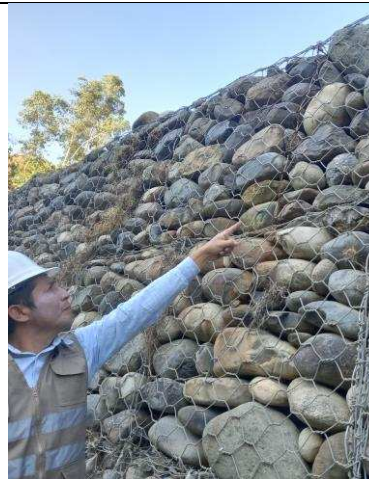
Foto N° 46: El alambre de amarre no es galvanizado prog. 0+055.
