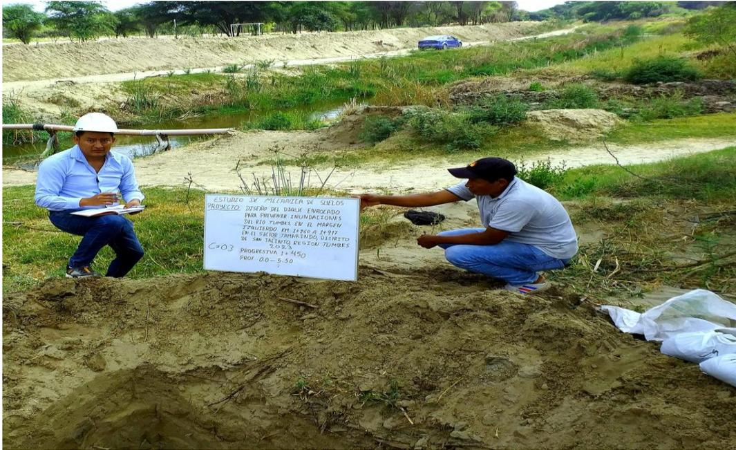
Figura 14: Recolección de datos en la Calicata C-03 en la progresiva 1+450.
