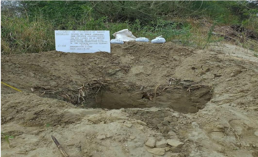
Figura 12: Se evidencia la calicata C-01 en la progresiva 1+200.
