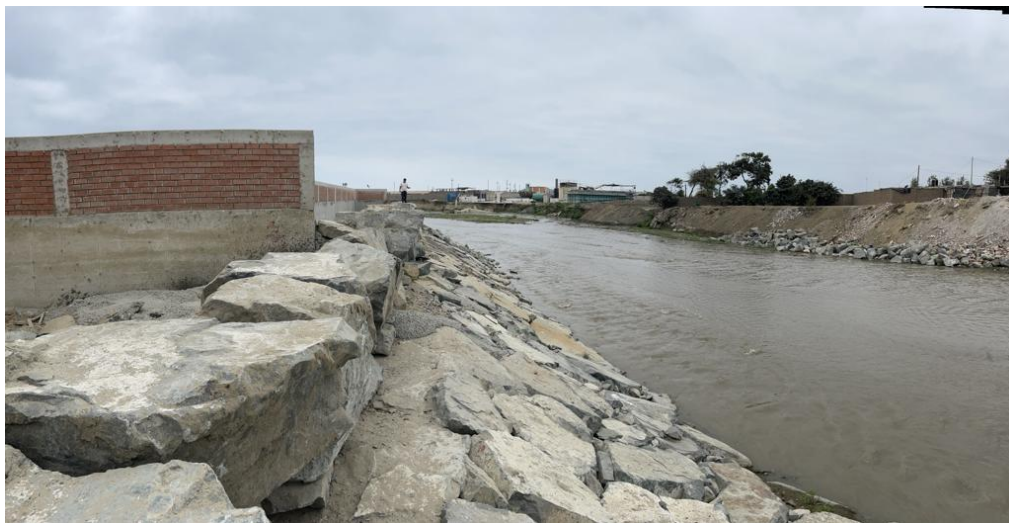
Figura 01. Reconocimiento del talud del dren Cascajal
