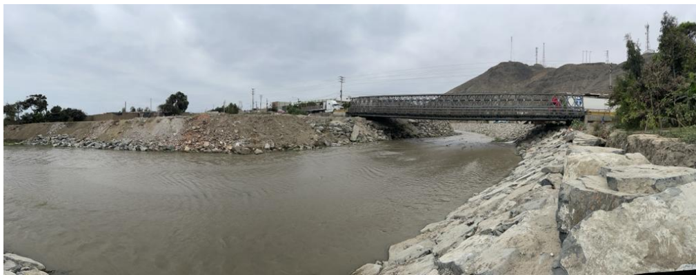
Figura 02. Sedimentación en el dren Cascajal
