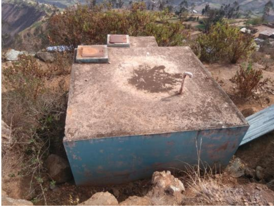
Imagen 12. Estado actual del reservorio
