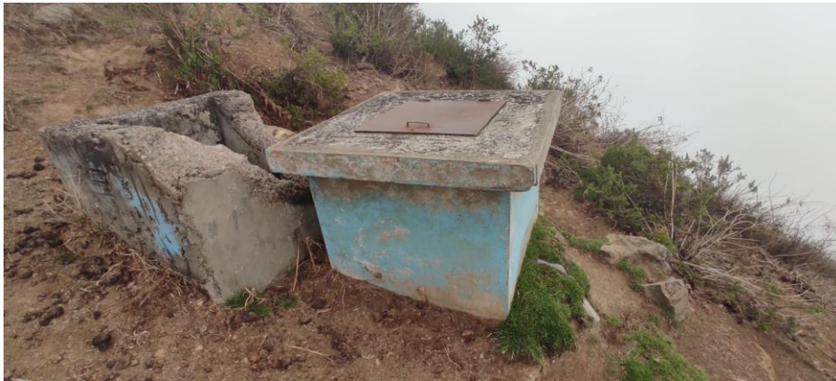
Imagen 5. Primera cámara rompe presión tipo 6
