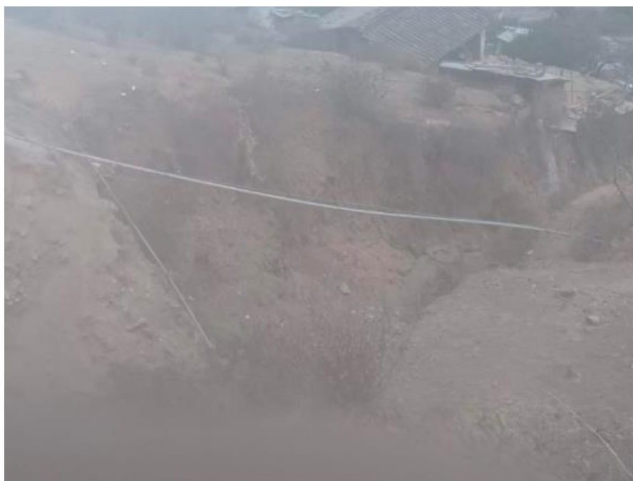
Imagen 13. Pase aéreo de la línea de aducción
