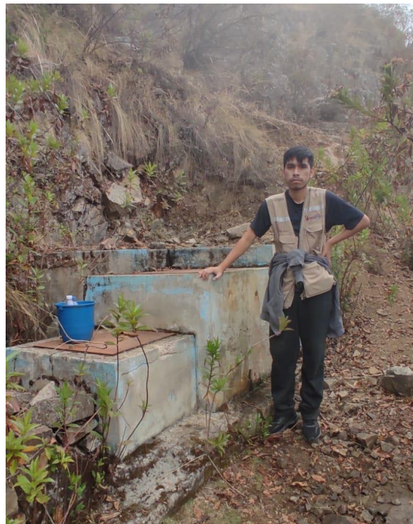
Fotografía 4. Visita a la captación del caserío de Cayán
