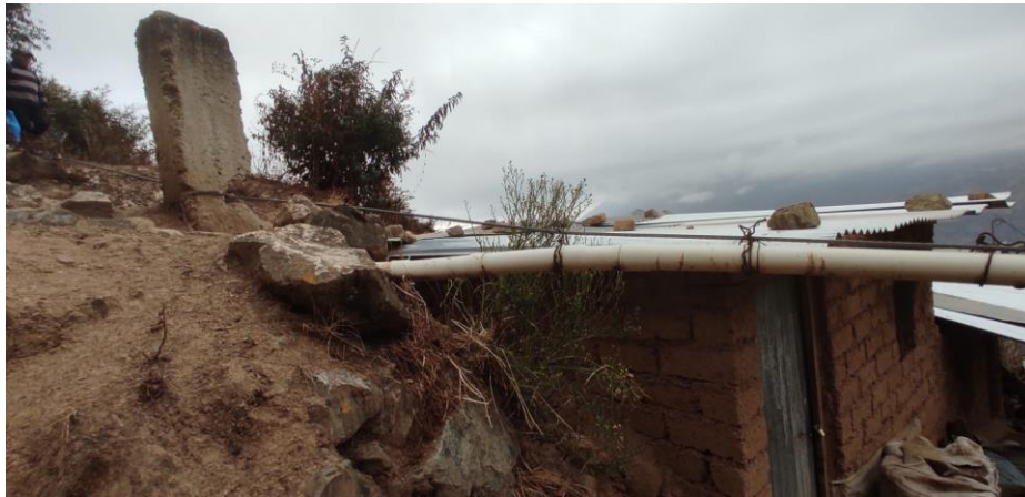
Imagen 14. Estructura del pase aéreo de la línea de aducción
