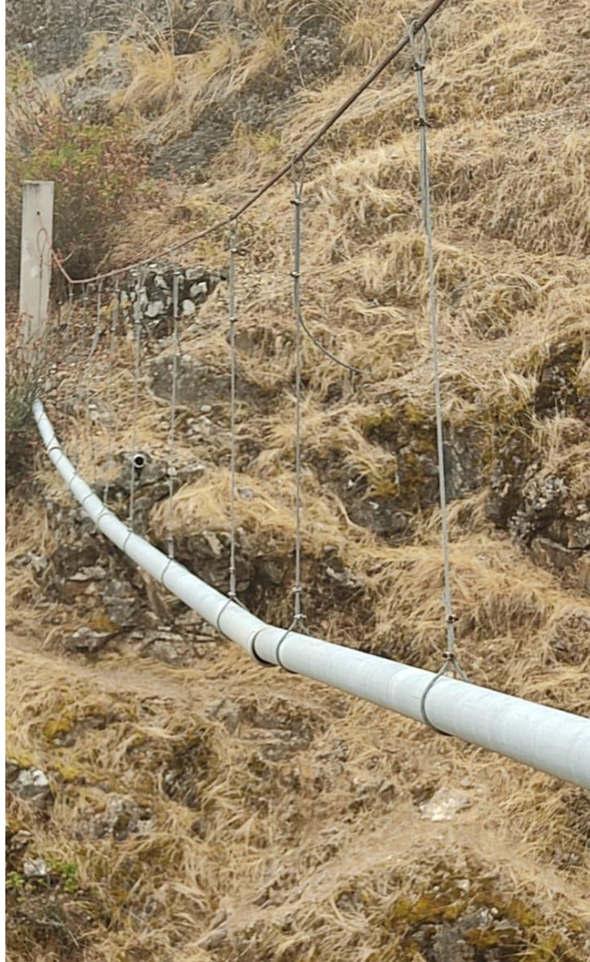
Imagen 4. Pase aéreo de la línea de conducción
