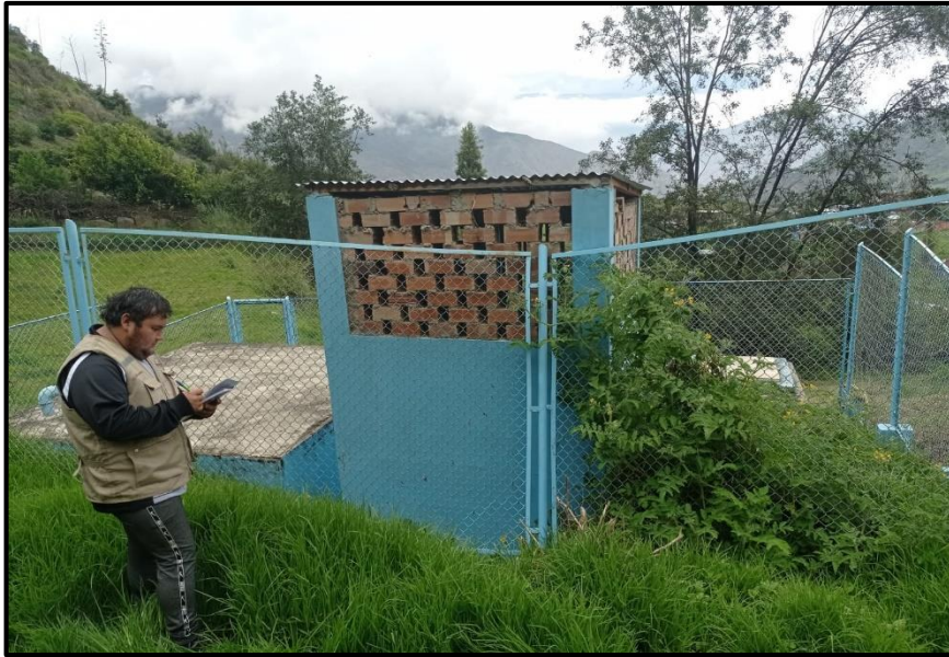
Figura 28: Cerco Perimétrico Deficiente Fuente: Evidencia de Campo
