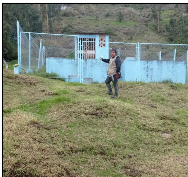
Figura 25: Reservorio del Caserío de Huambo Fuente: Evidencia de Campo
