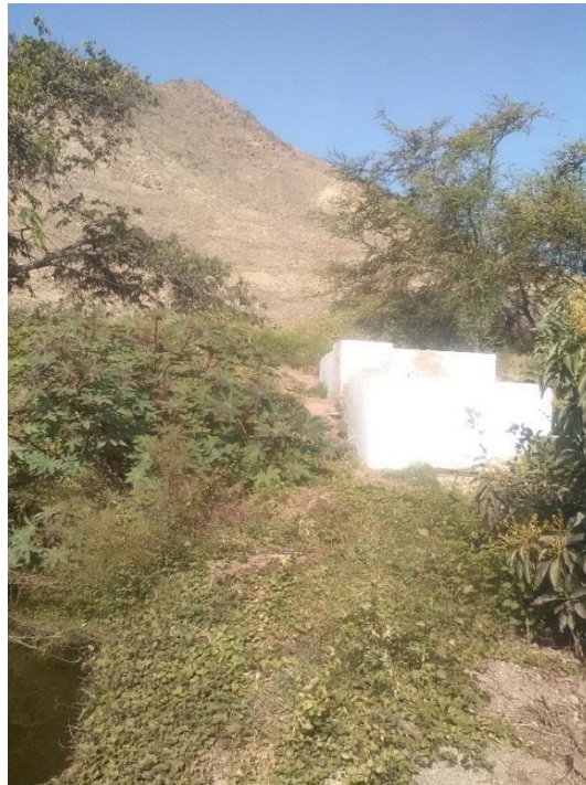
Figura 46. Vista del reservorio del caserío El Olivar. Fuente: Elaboración propia – 2019.
