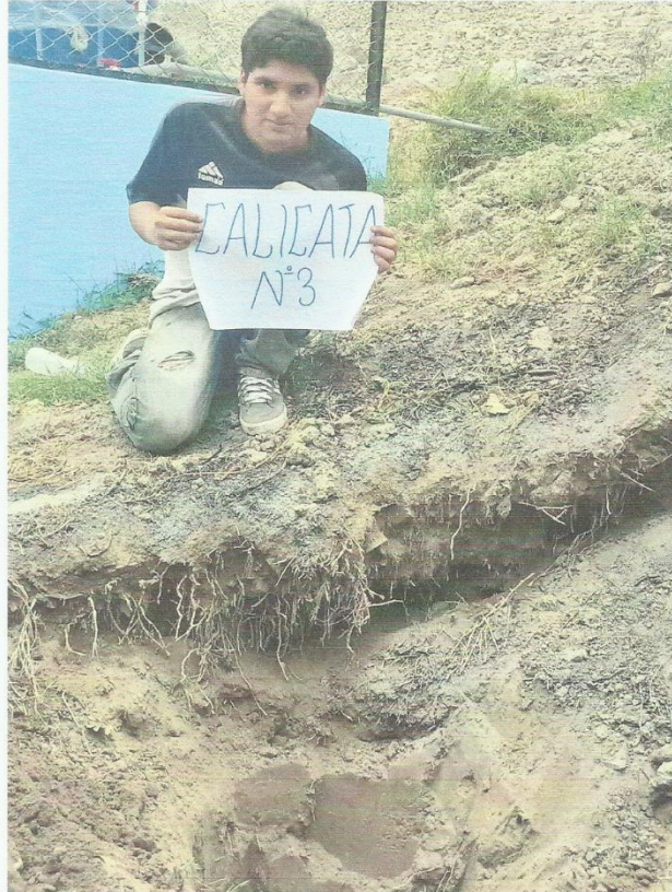
Fotografía N° 03: : Excavación de calicata 03
