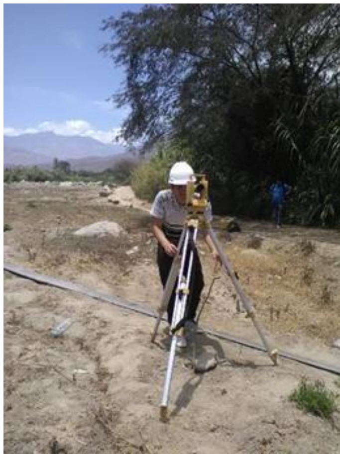
Figura 47. Realizando el levantamiento topográfico de la línea de conducción.
