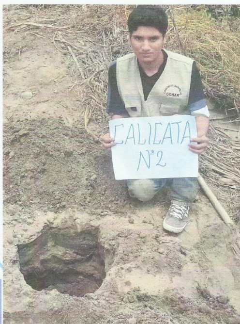
Fotografía N° 02: Excavación de calicata 02
