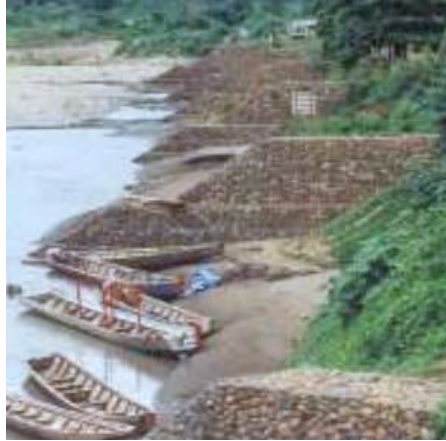
Figura 01 Espigón en orilla erosionada
