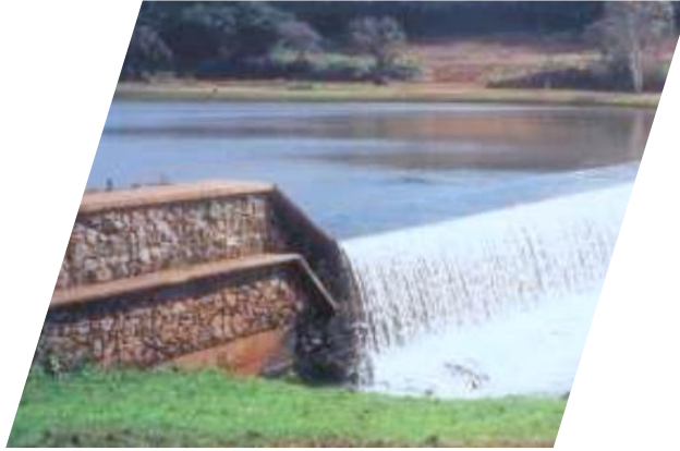
Figura 02 Dique de gavión
