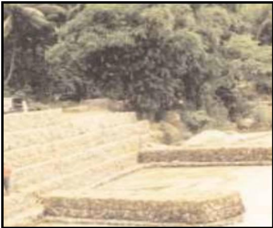
Figura 2.3: Obra deflectora (Espigón).
