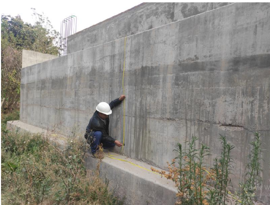
Figura 5.4: Muros de concreto para protección por inundación.
